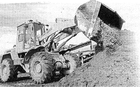
На площадке по компостированию осадка сточных вод.
