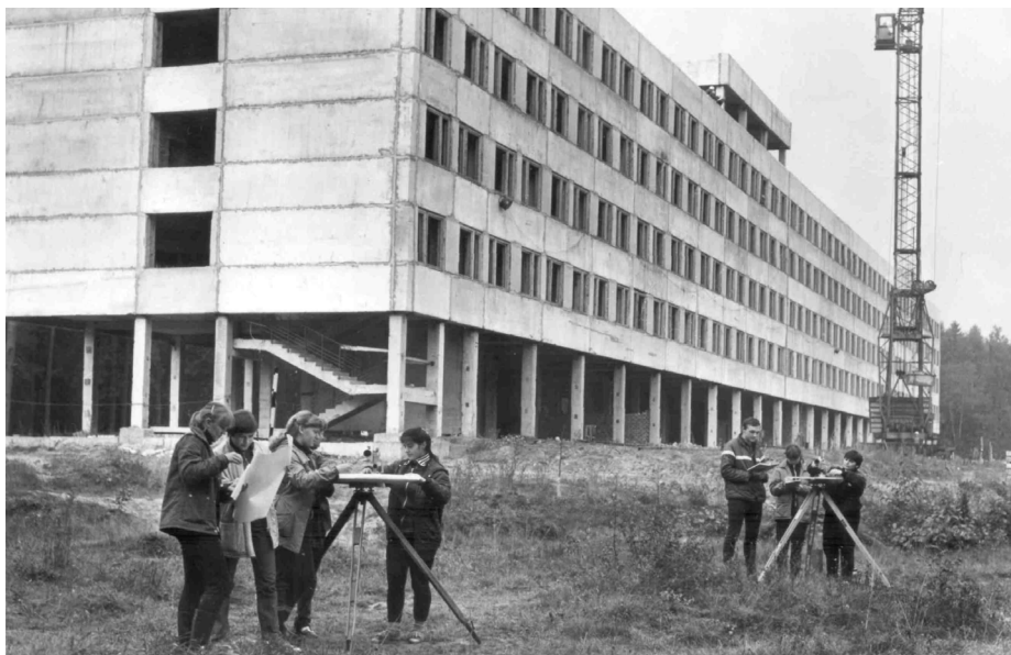
На стройплощадке нового корпуса
