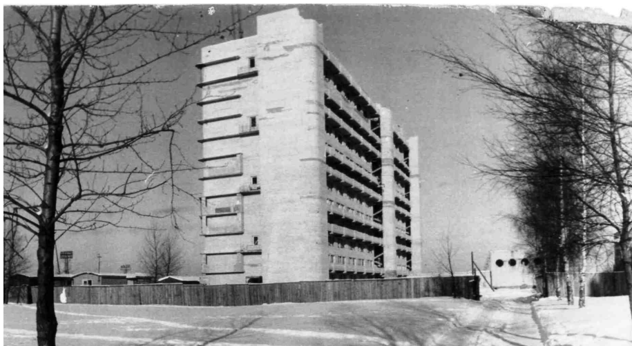
Строительство «Бастилии» 1980 год
