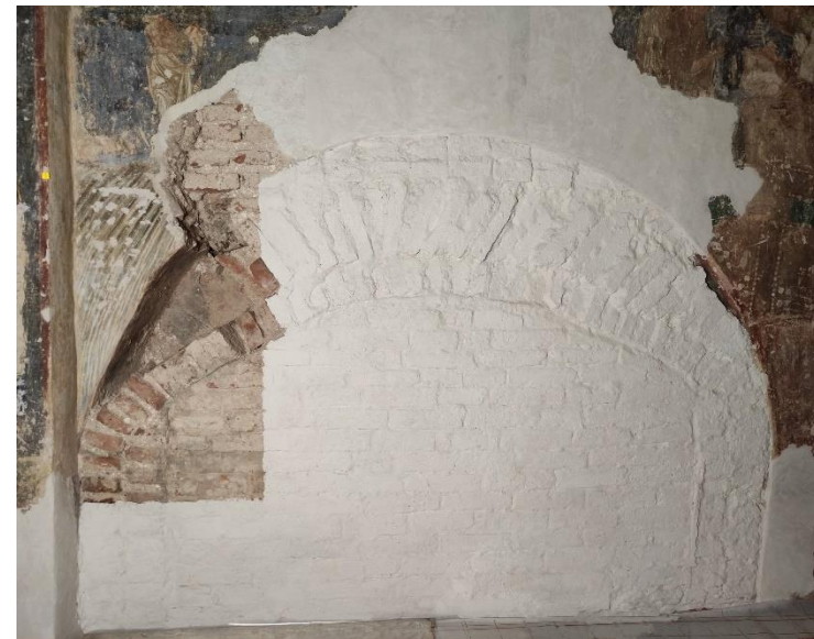
Частичное вскрытие арочной ниши северного дверного проема
