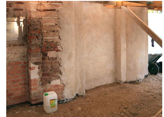
Нанесение штукатурного слоя составами Remmers
