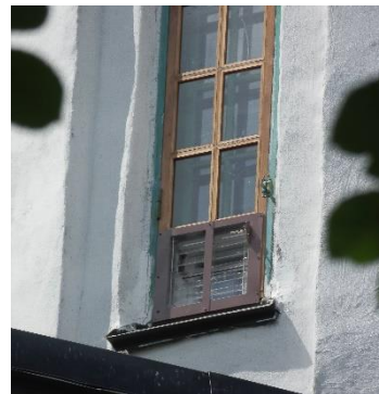
Установка аэрационных устройств с возможностью регулировки режимов «Зима – лето»
