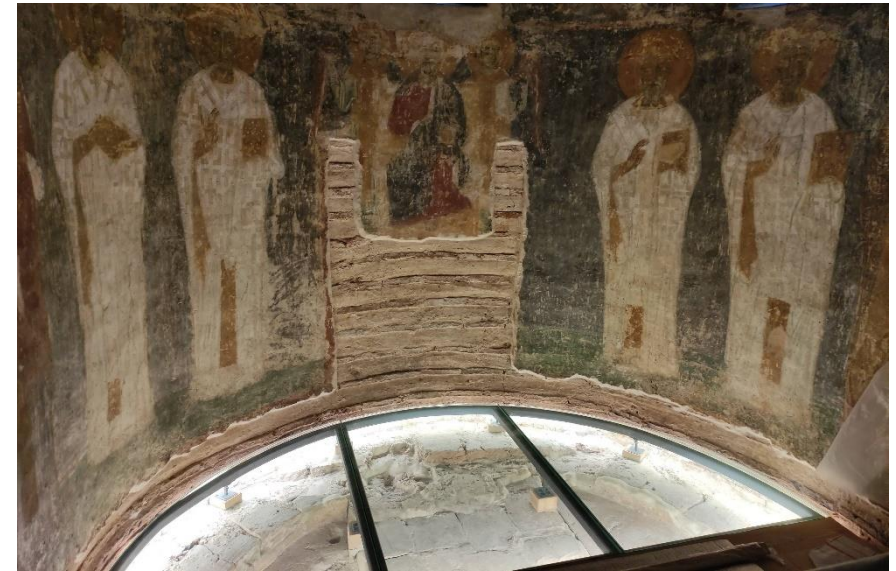
Стеклянный пол в алтаре над фрагментами растворного пола, скамьи синтрона и Горнего места
