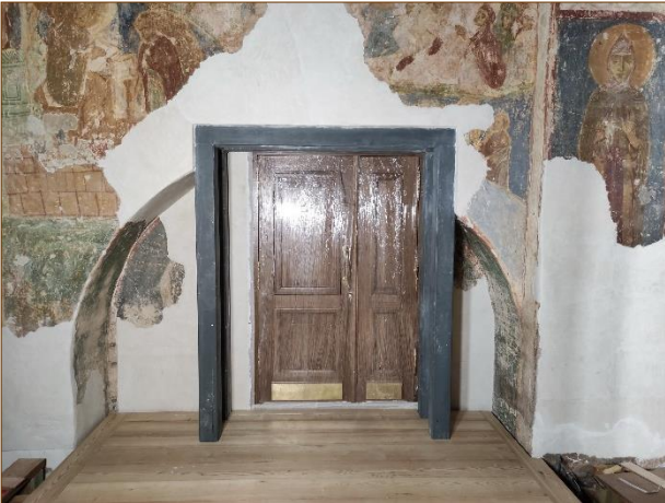
Усиление южной стены металлическими каркасами. Раскрытие арки XII в.
