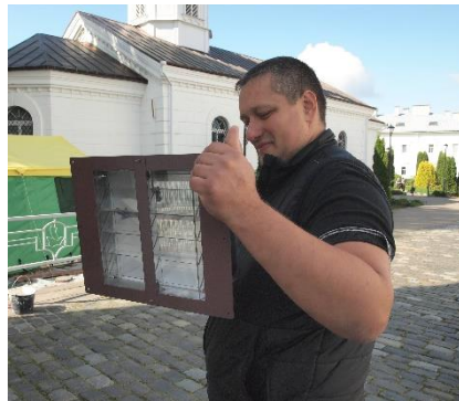
Установка аэрационных устройств с возможностью регулировки режимов «Зима – лето»
