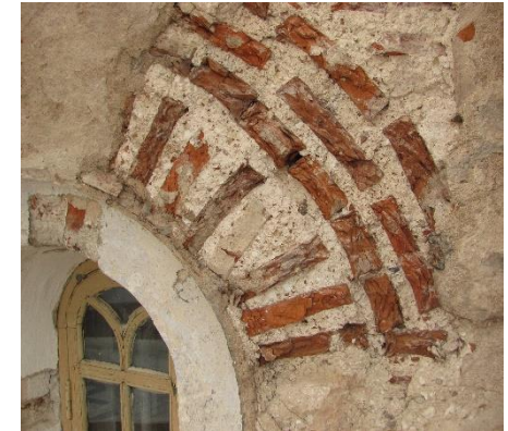
Срубленная бровка над окном барабана
