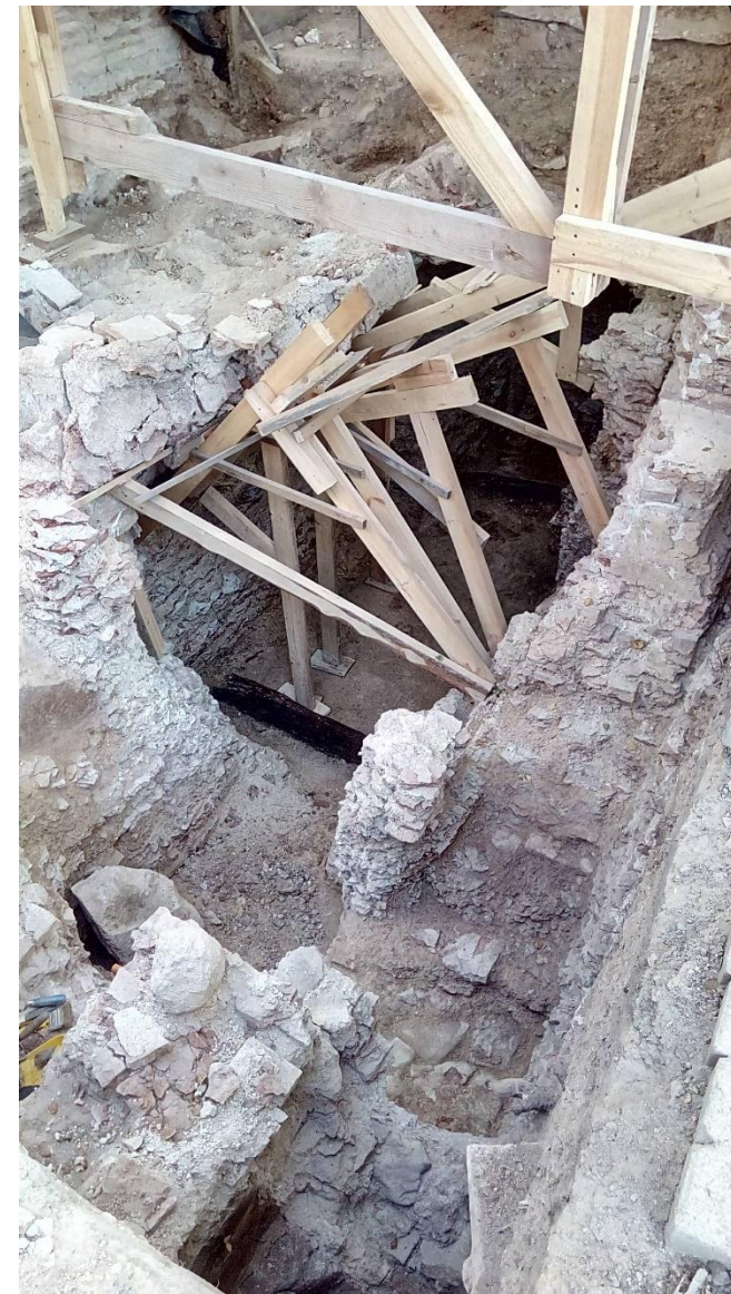
Сохранившиеся фрагменты главного свода и внутристенной лестницы.
