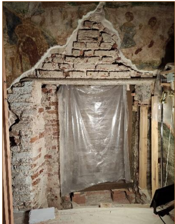
Южный дверной проем до начала работ
