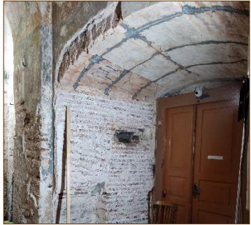
Усиление арки западного дверного проема
