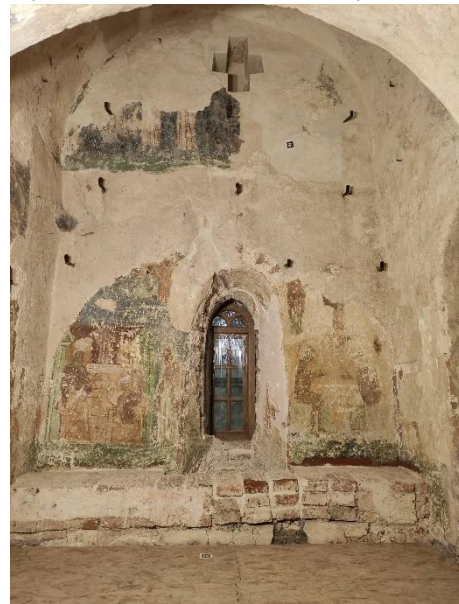
Южная стена. Скамья и срубленная арка оконной ниши
