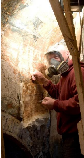
Процесс отслоения масляной живописи XIX в. и раскрытия фресковой росписи XII в.
