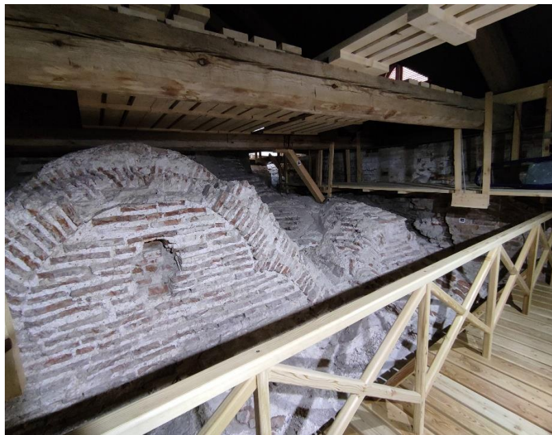
Устройство экспозиционной зоны, смотровой площадки и подвесных ходовых мостков
