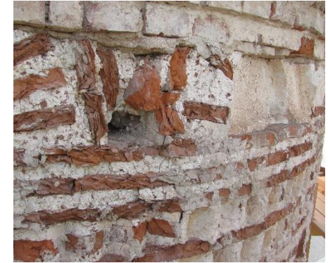
Фрагмент арочного карниза с нишами в два уступа
