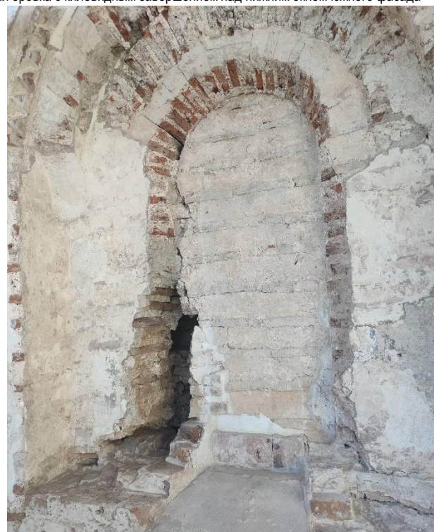
Надпортальная уступчатая ниша северного фасада после раскрытия
