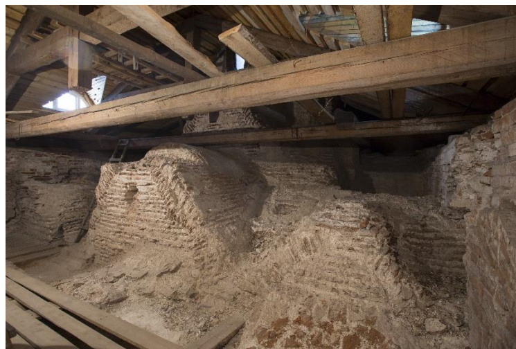
Трехлопастные кокошники закомар в чердачном пространстве
