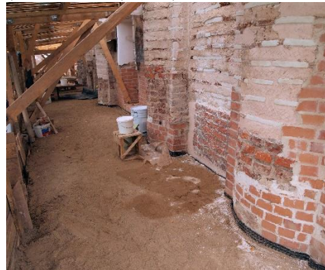
Вычинка стен и устройство вертикальной гидроизоляции
