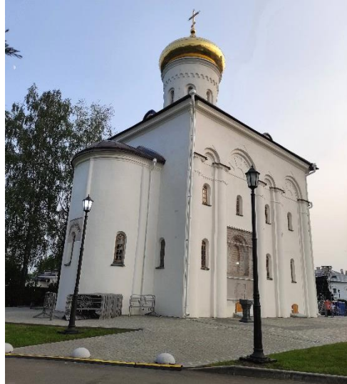
Прихрамовая зона. Установка новых уличных фонарей
