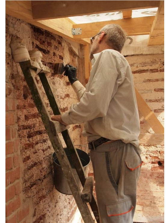
Нанесение камнеукрепителя Remmers KSE-100 и KSE-300
