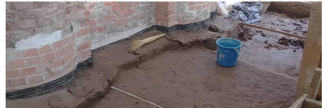
Применение гидроизоляционной мембраны для защиты стен. Устройство глиняной отсыпки
