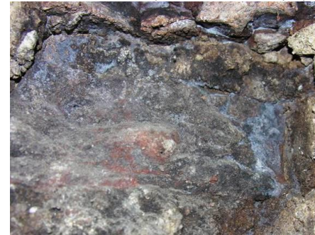
Налет микроскопических грибов на кирпиче
