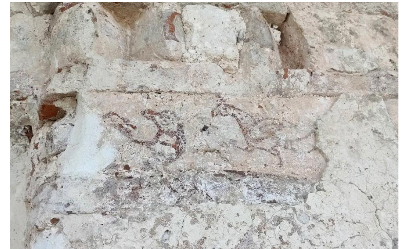
Две птицы. Роспись на затирке лицевой кладки под штукатуркой галереи XII в.
