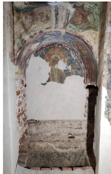
Малый аркосолий северной стены
