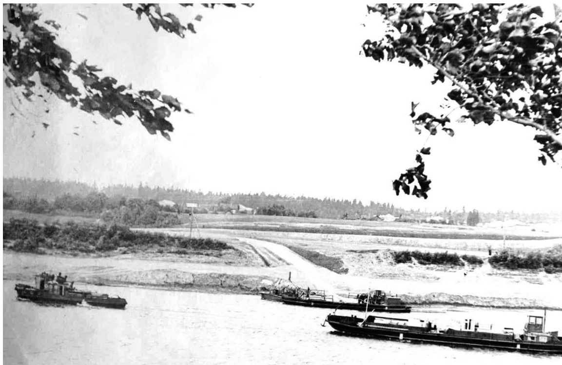
Панорама строительной площадки. Июнь 1958 г. (из альбома трудовой летописи строительного треста № 16 «Нефтьстрой»)
