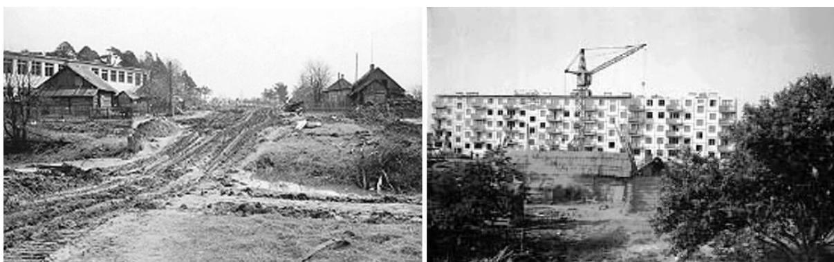
Рис. 2.26. Общий вид строительства микрорайона № 3. На переднем плане строения деревни Слобода
