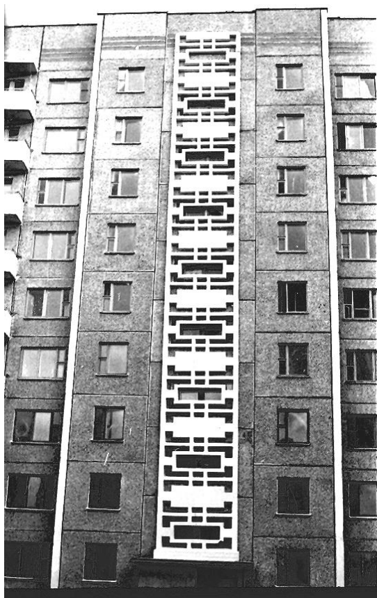
Рис. 3.38. Фрагмент крупнопанельного жилого дома с фасадной декоративной панелью-решеткой лестничной клетки
