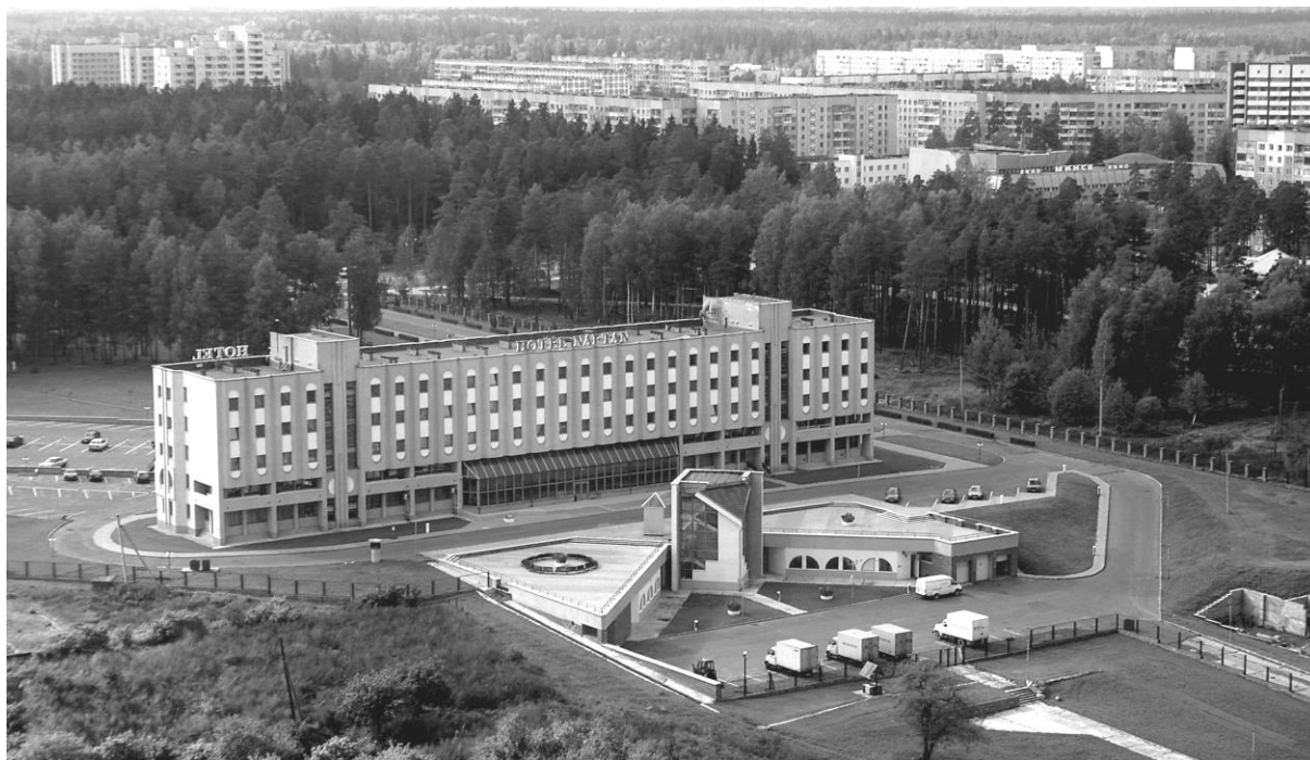
Рис. 4.33. Общий вид гостиницы «Нафтан». На переднем плане строения второй очереди строительства
