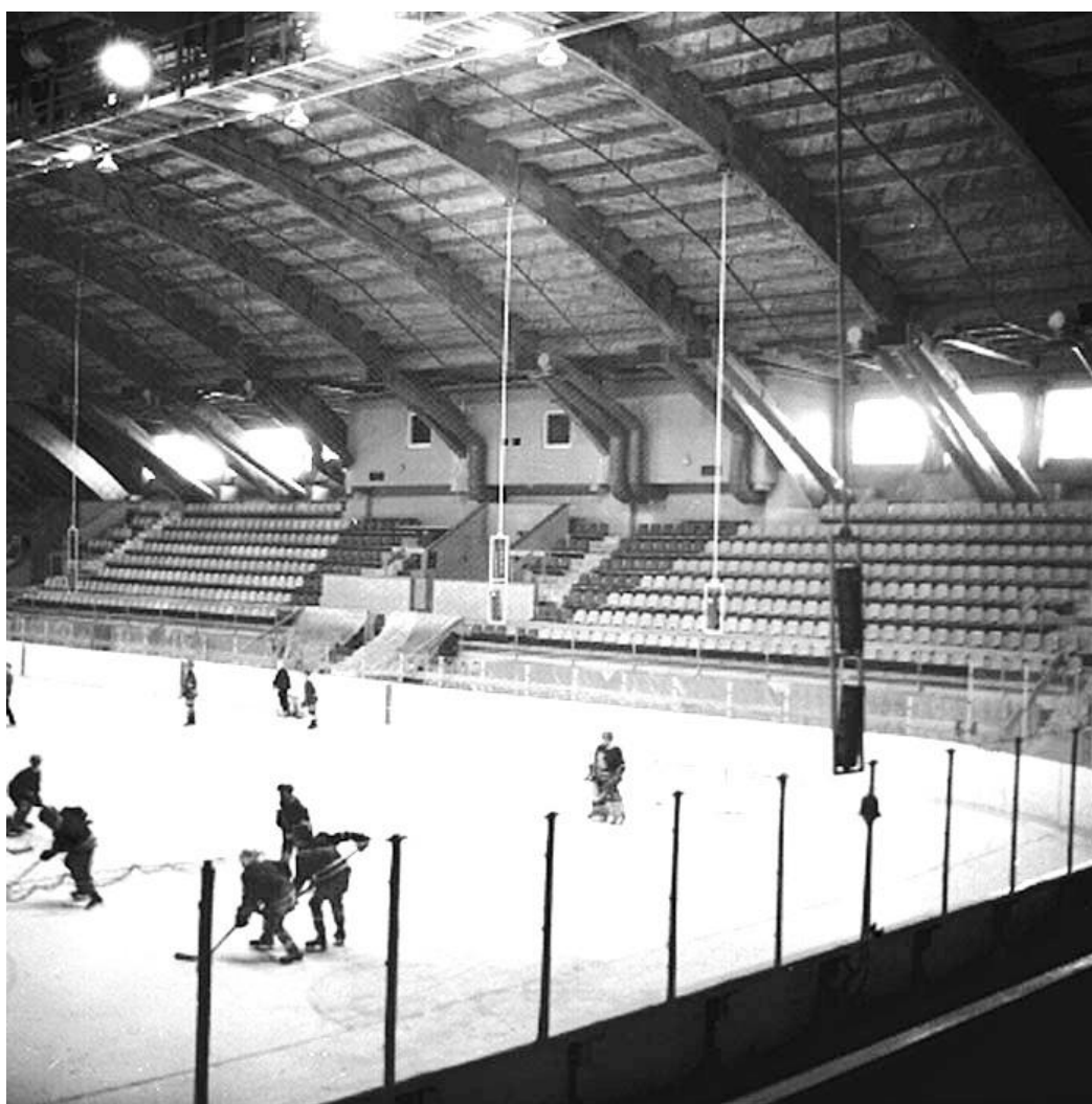
Рис. 4.27. Интерьер Ледового Дворца после завершения строительства
