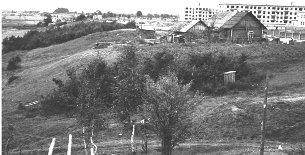
Рис. 1.26. Общий вид строительства квартала «многоэтажных» домов. На переднем плане деревня Слобода
