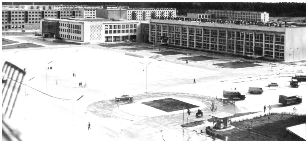
Рис. 2.9. Общий вид строительства центральной площади жилого района. 1967 г.
