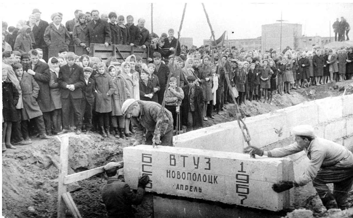
Рис. 2.35. Начало сооружения учебно-лабораторного корпуса высшего технического учебного заведения. Закладка плиты – фундаментного блока с памятной надписью
