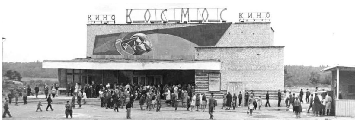
Рис. 1.40. Кинотеатр «Космос» после завершения строительства. 1963 г.
