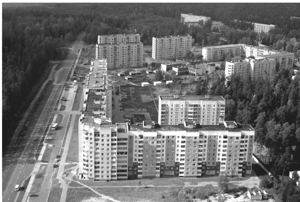
Рис. 4.10. Общий вид жилой застройки по улице Слободской в период строительства
