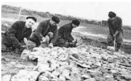
Рис. 1.46. Устройство мостовой на участке «Экимань – Слобода»
