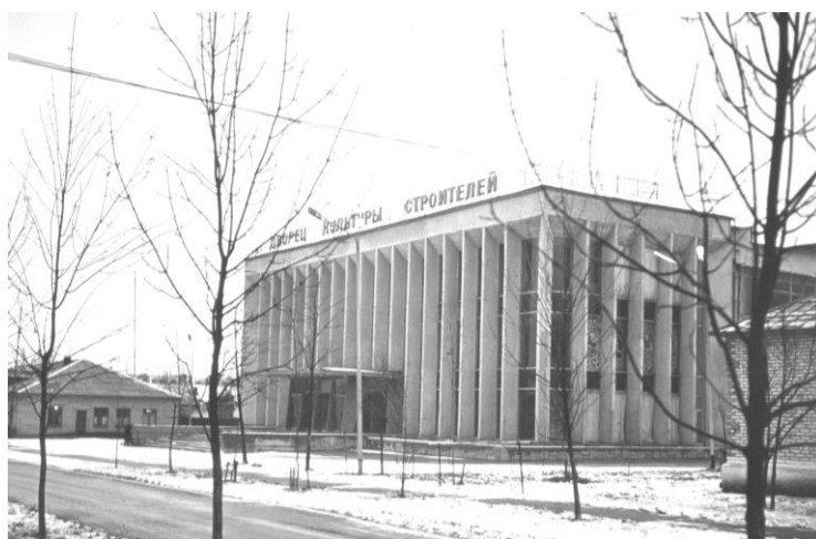
Рис. 2.41. Общий вид здания Дворца культуры строителей после завершения строительства
