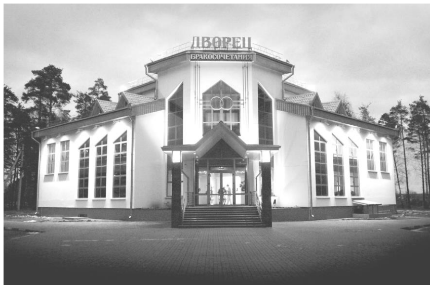
Рис. 4.30. Дворец бракосочетаний после ввода в эксплуатацию
