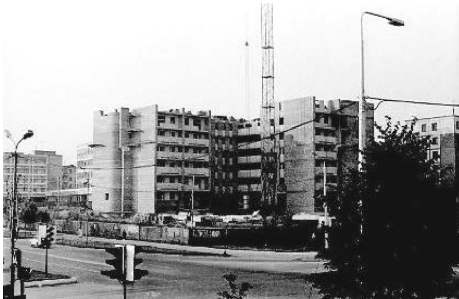
Рис. 3.56. БелНИИПградостроительства (Новополоцк). 12-этажный жилой дом на пересечении улиц Калинина и Молодежной в период строительства
