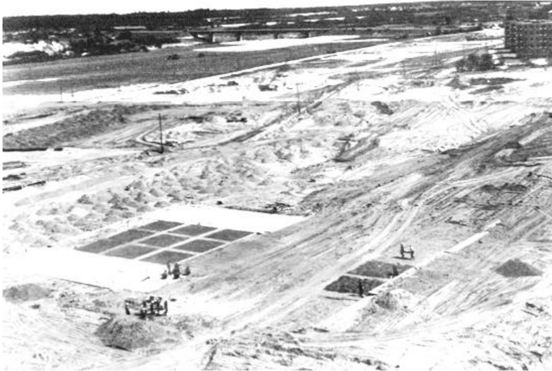
Рис. 2.39. Строительные работы по сооружению стадиона «Атлант». 1967 г.
