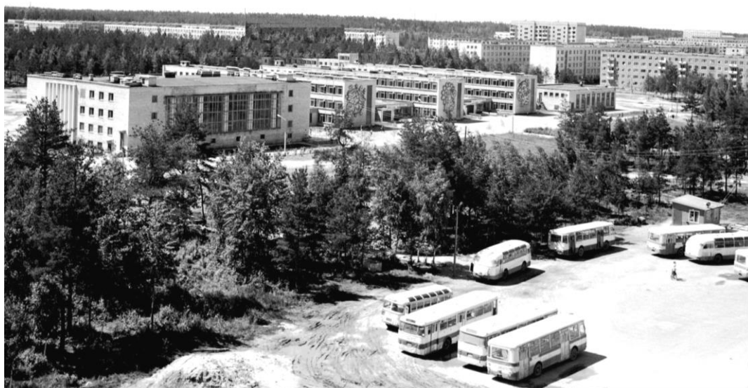
Рис. 2.34. Общий вид средней общеобразовательной школы № 4 после завершения строительства
