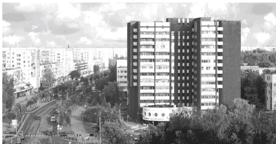
Рис. 3.57. 12-этажный жилой дом на пересечении улиц Калинина и Молодежной после завершения строительства
