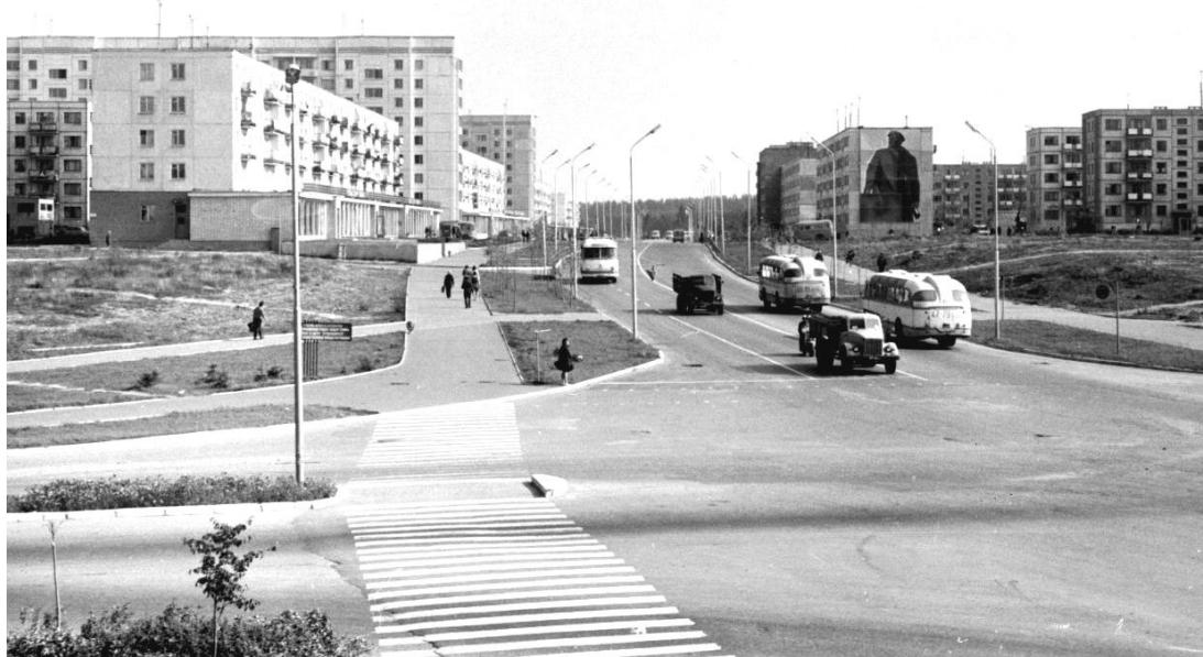
Рис. 3.35. Общий вид улицы Молодежной с первыми в городе девятиэтажными крупнопанельными жилыми домами серии 1-464Д. 1973 г.
