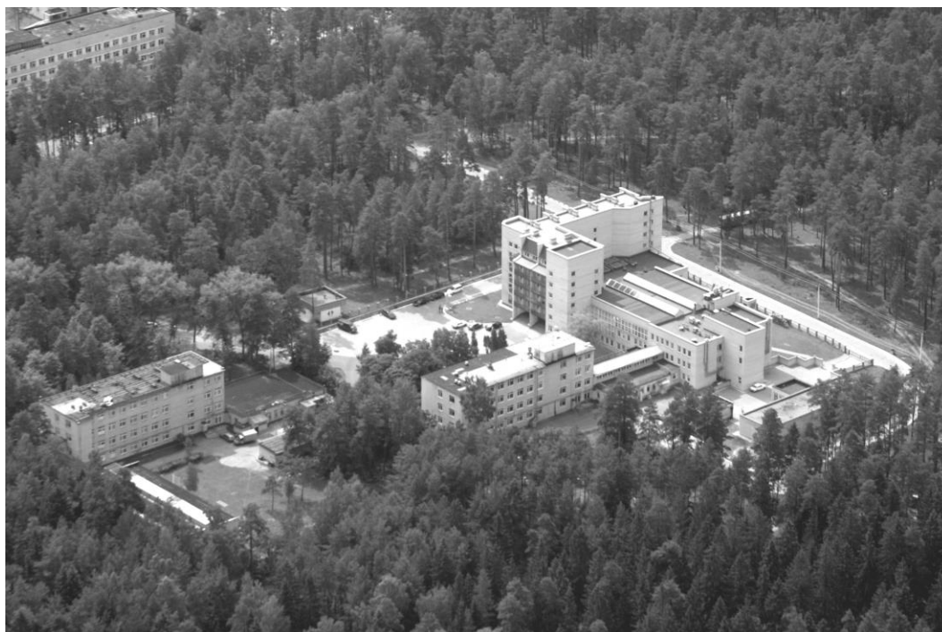
Рис. 4.39. Общий вид комплекса санатория-профилактория ОАО «Нафтан» после окончания строительства
