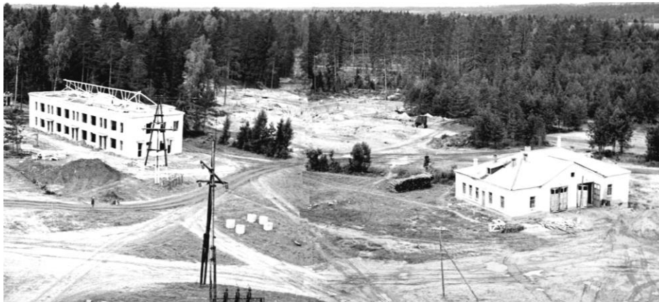
Рис. 1.37. Панорама начала строительства городской больницы на 240 коек.
