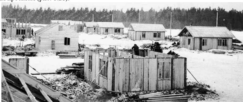
Рис. 1.28. На стройке сборно-щитовых жилых домов в районе индивидуального строительства. 1959 г.
