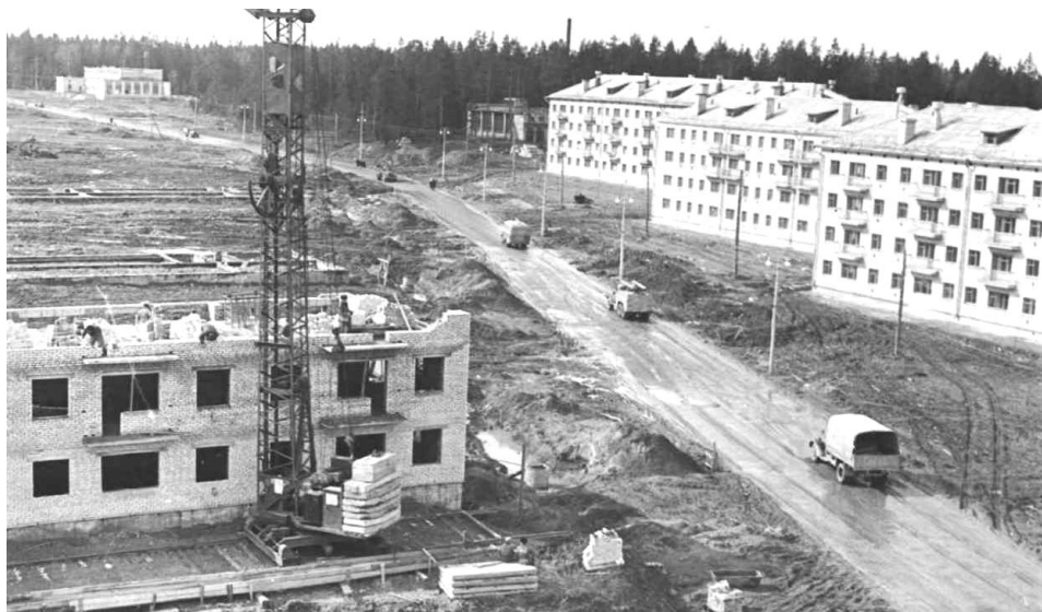
Рис. 1.18. Начало сооружения микрорайона № 1 вдоль улицы Нефтяников (Ктаторова) 1960 г.
