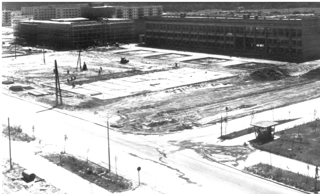
Рис. 3. 47. 1967 г. Общий вид строительства центральной площади жилого района.
