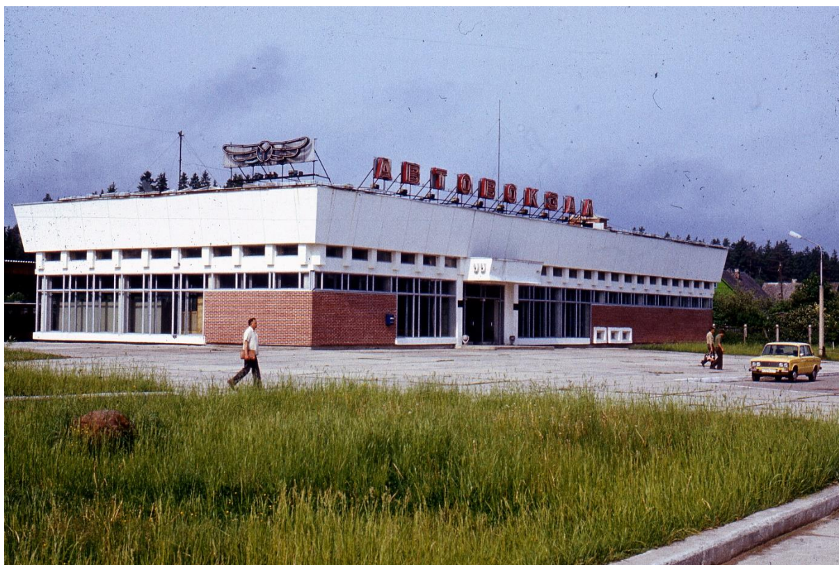
Рис. 4. 103. Общий вид автовокзала после завершения строительства.
