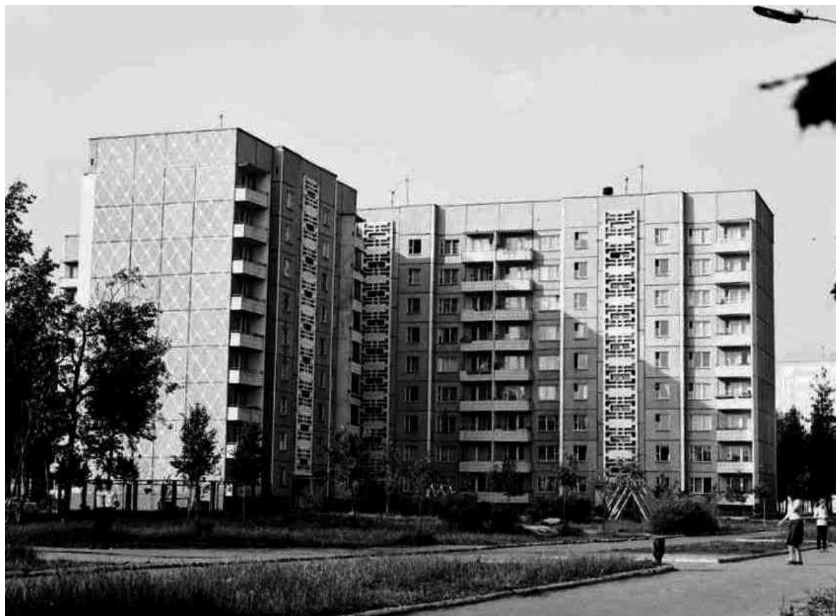
Рис. 4. 82. Жилой дом по генплану № 542 (ул. Молодежная, 128), где впервые опробовано устройство навесных решеток на панелях лестничных клеток крупнопанельных жилых домов
