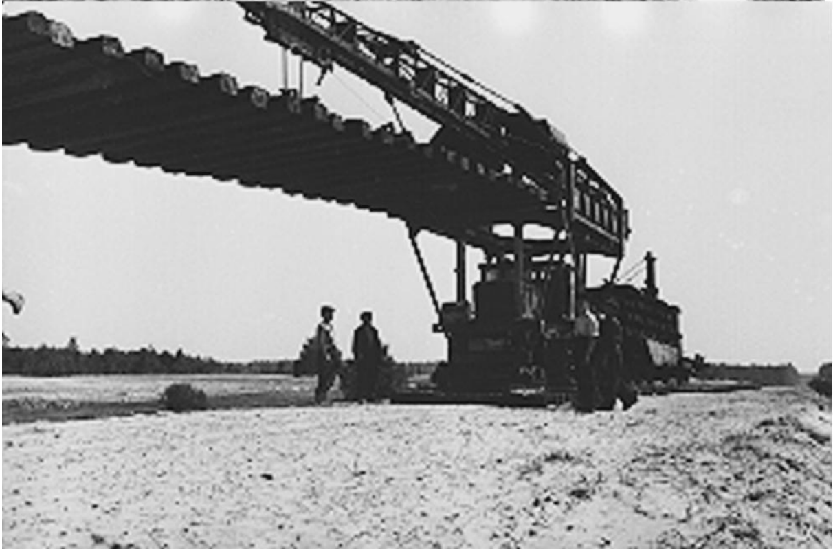
Рис. 2.34. Работы по сооружению железнодорожных путей к станции Новиково.
