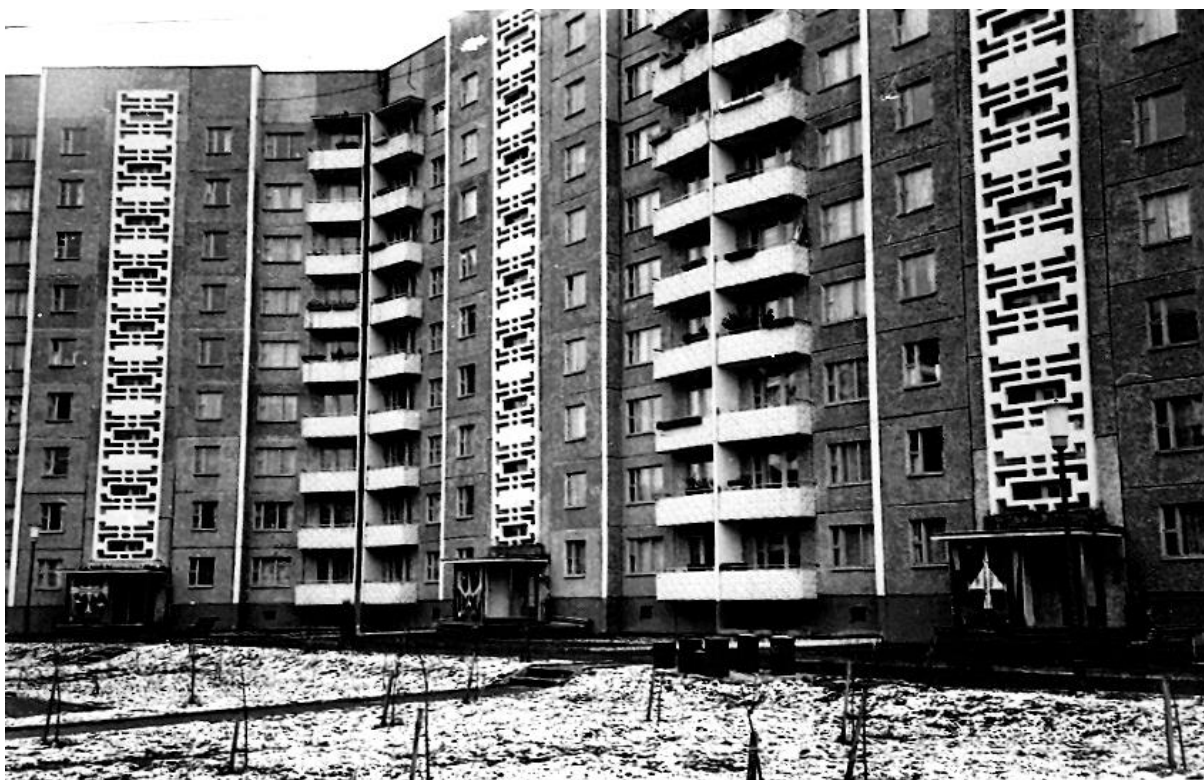
Рис. 4. 116. Фрагмент жилых домов по улице Дружбы, 3, 5 после завершения строительства
