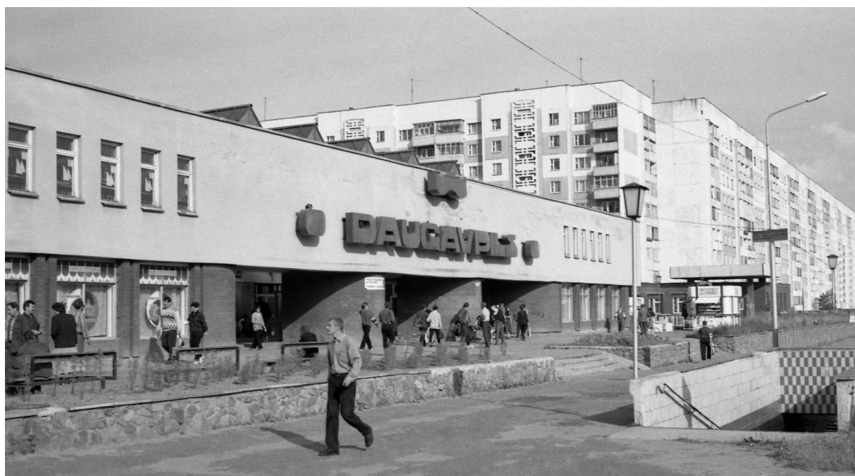
Рис. 6. 5. Общий вид общественно-торгового центра «Даугавпилс» (Зодиак) в микрорайоне № 7 по улице Молодежной. Архитектор М.М. Царик
