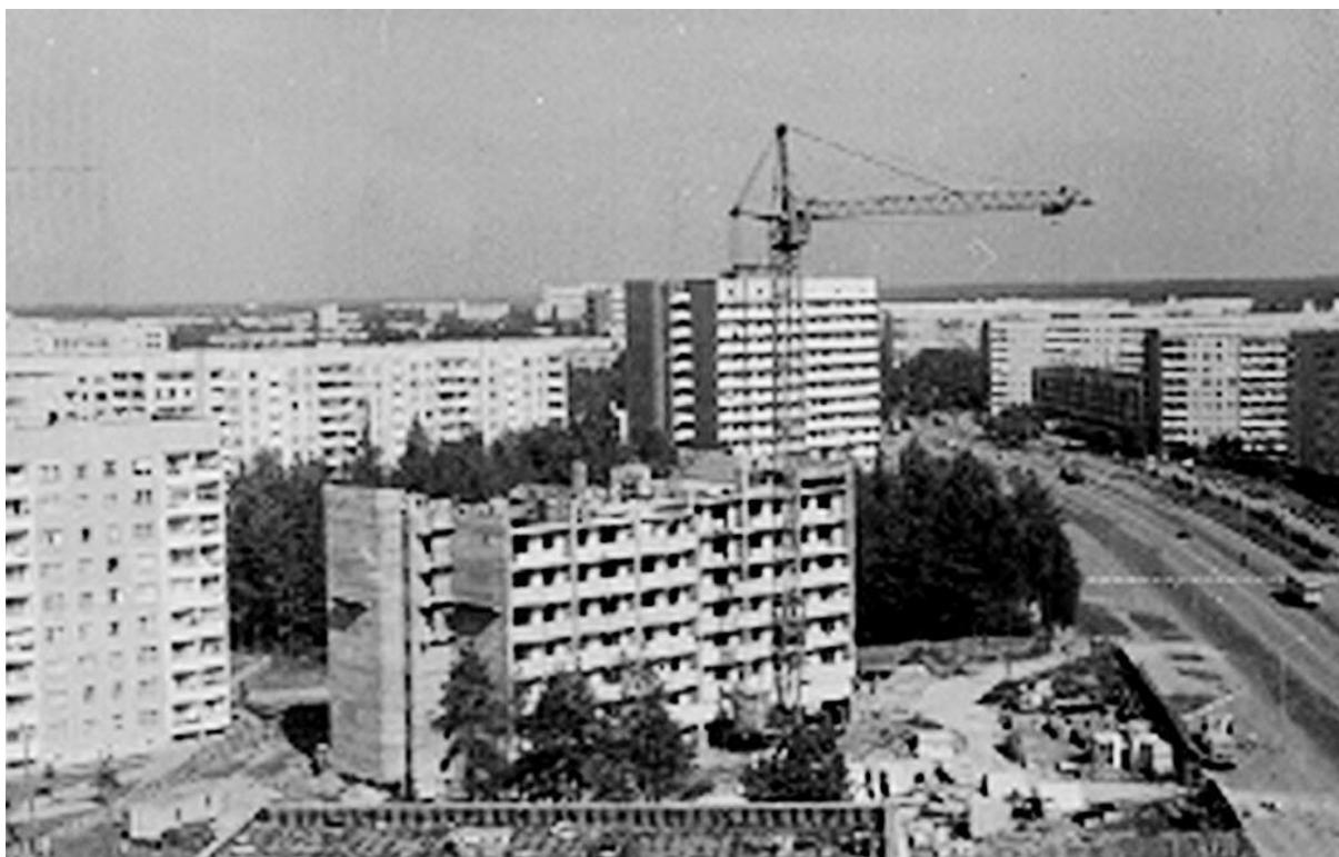
Рис. 5. 44. Общий вид строительства двенадцатиэтажных жилых домов по улице Молодежной в микрорайоне № 6.
