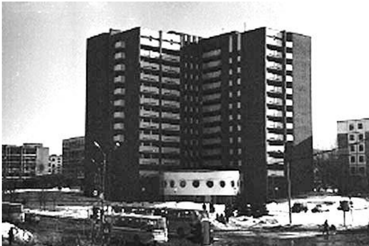
Рис. 5. 62. Общий вид 12-этажного жилого дома на пересечении улиц Калинина и Молодежной после завершения строительства
