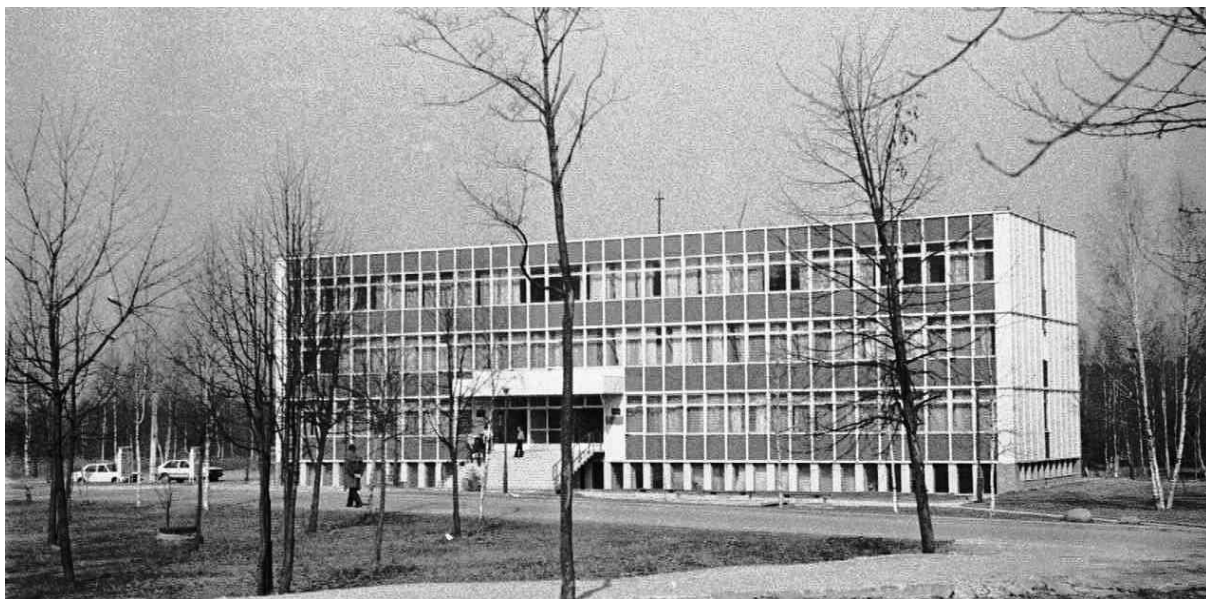
Рис. 4. 113. Административное здание по ул. Парковая,1. Общий вид
