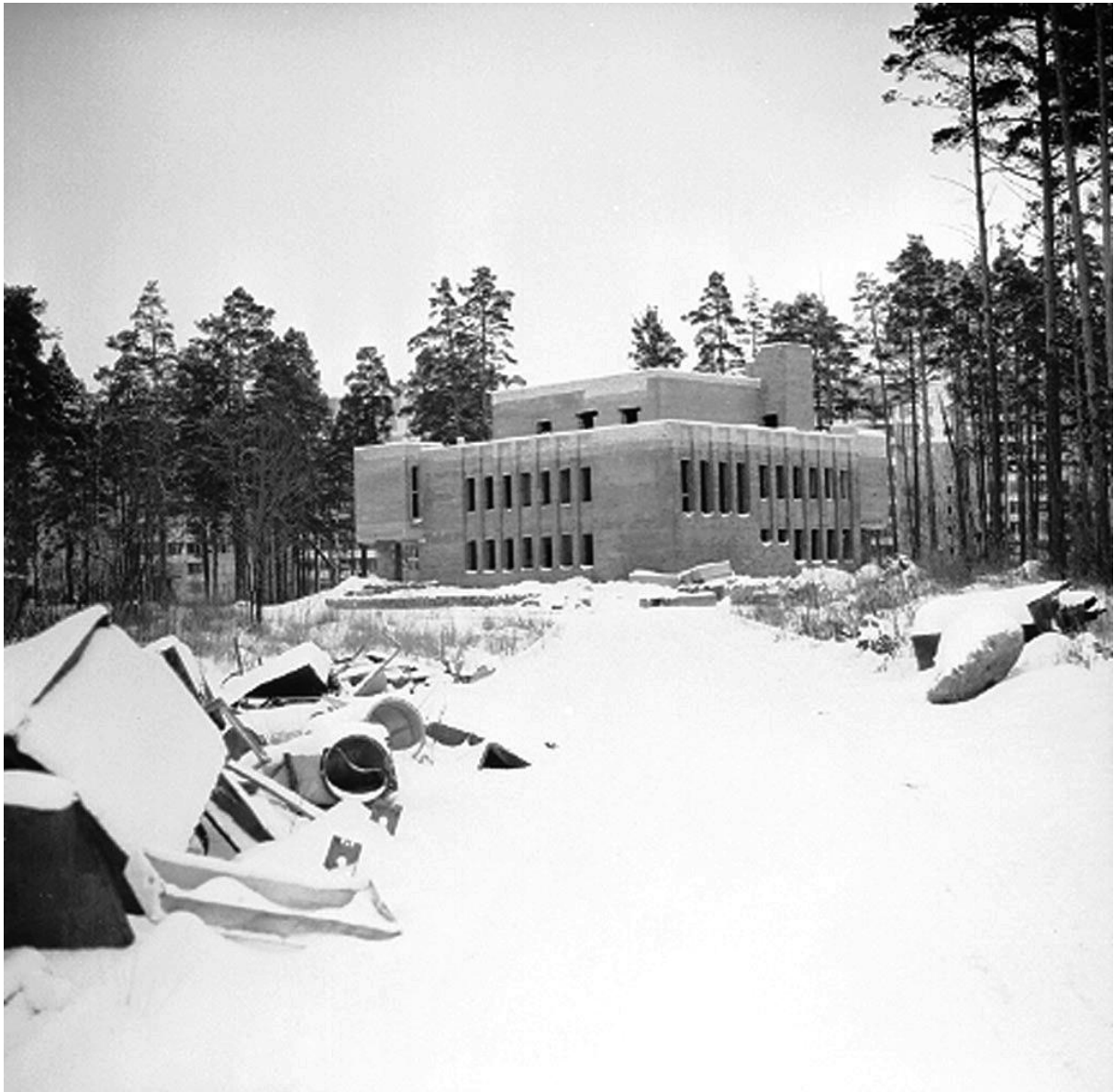
Рис. 6. 22. Общий вид недостроенного Дворца бракосочетаний. 1993 г. Архитектор М.М. Царик
