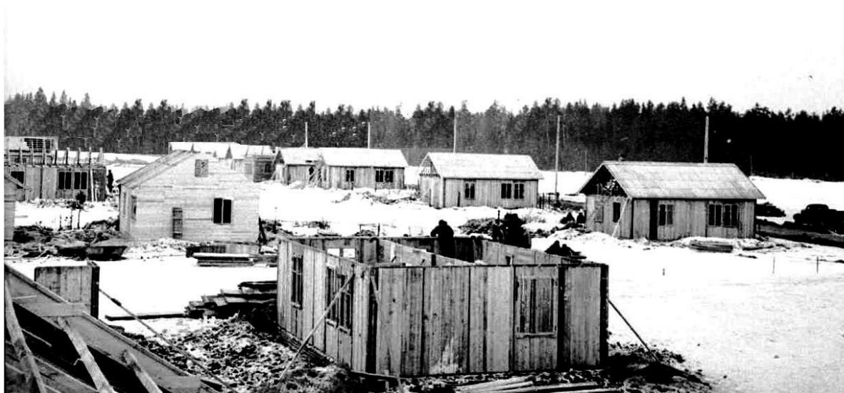
Рис. 2.83. Вверху: строительство коттеджей по улице Двинской. Внизу: сборка щитовых (финских) домов бригадой Ловинецкого. Из коллекции музея истории Новополоцка ( КП-2204-66 и КП 2204-5)
