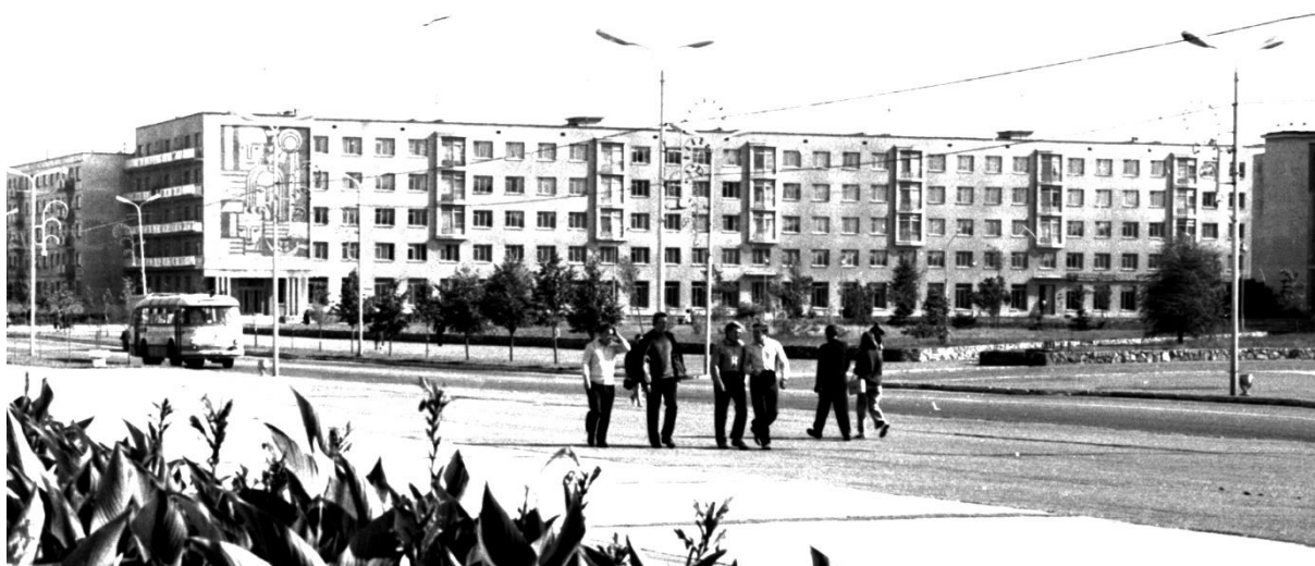
Рис. 4.26. Общий вид жилого дома по ул. Юбилейной после завершения строительства
