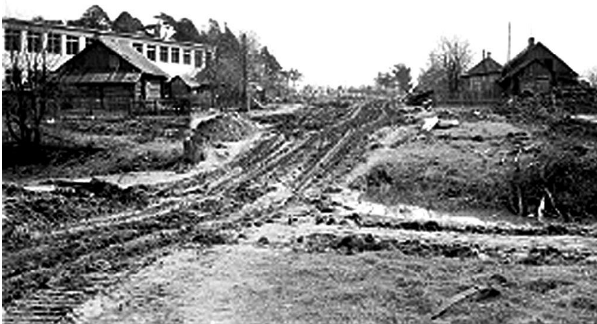
Рис. 3. 23. Общий вид строительства на территории микрорайона № 3.
