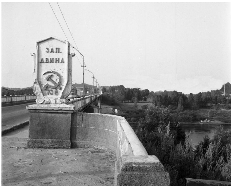
Рис. 2.99. 1962 г. Шильда при въезде на мост через Западную Двину.
