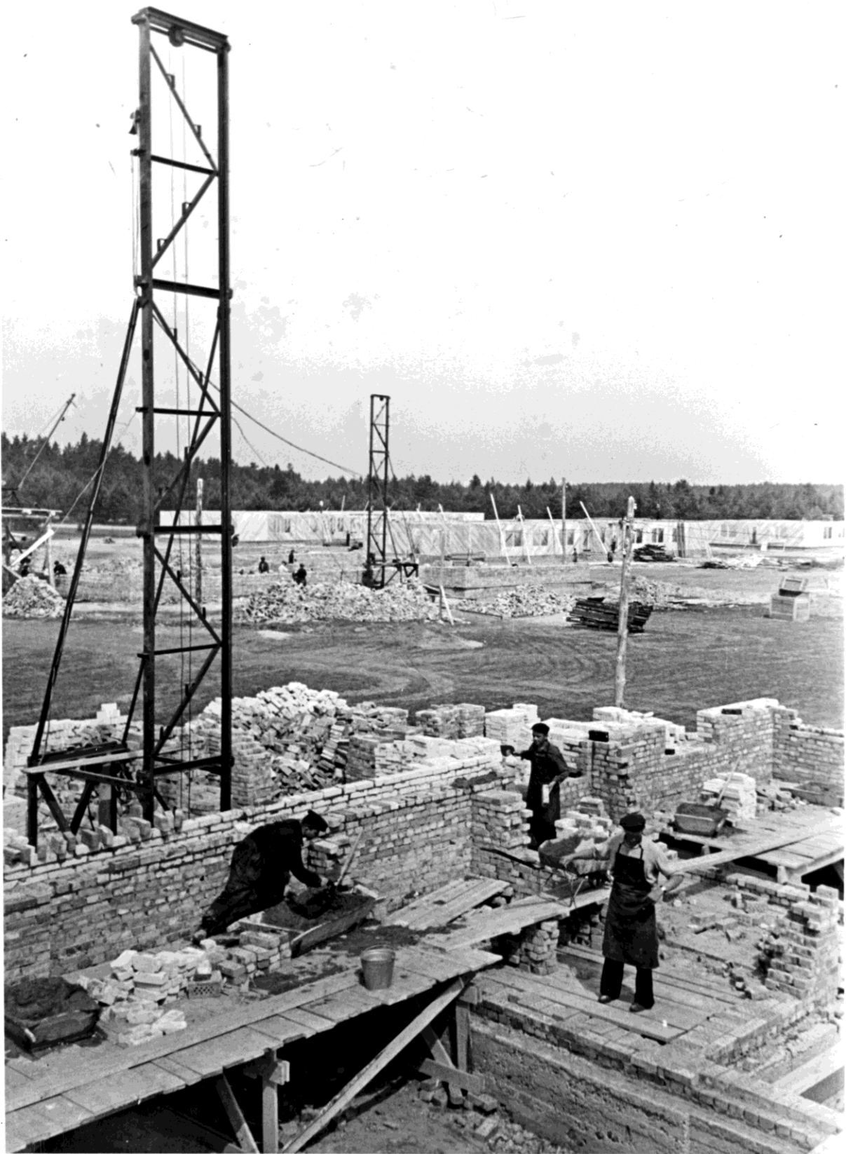
Рис. 2.18. Панорама строительства жилого городка со стороны котельной
