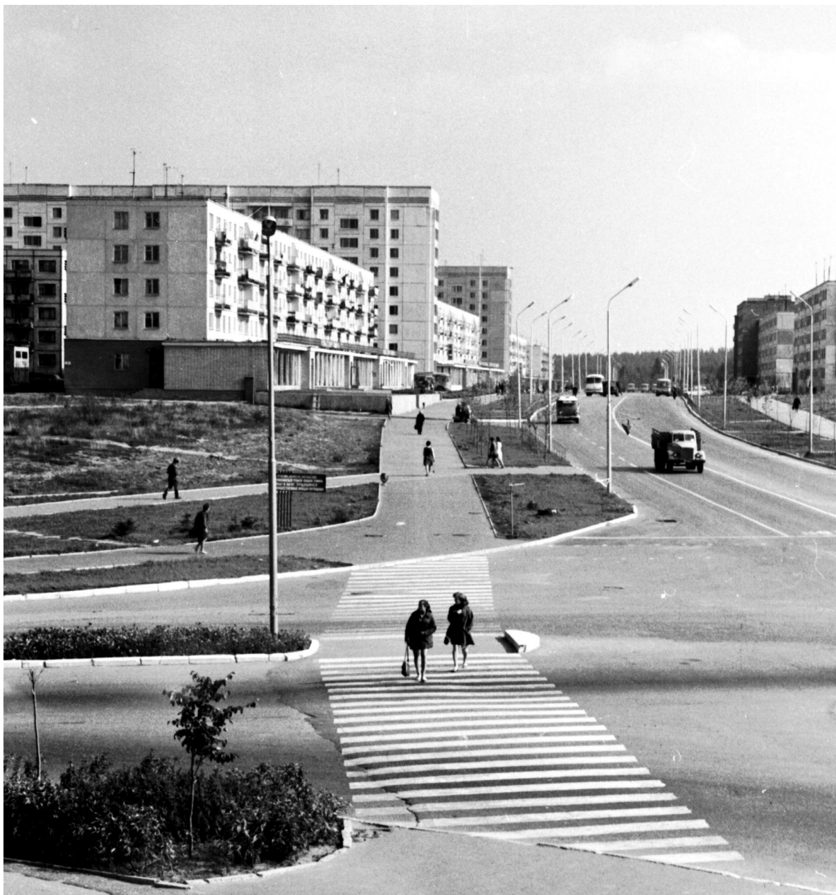
Рис. 4. 47. Общий вид улицы Молодежной с первыми в городе девятиэтажными крупнопанельными жилыми домами серии 1-464Д. 1973 г.
