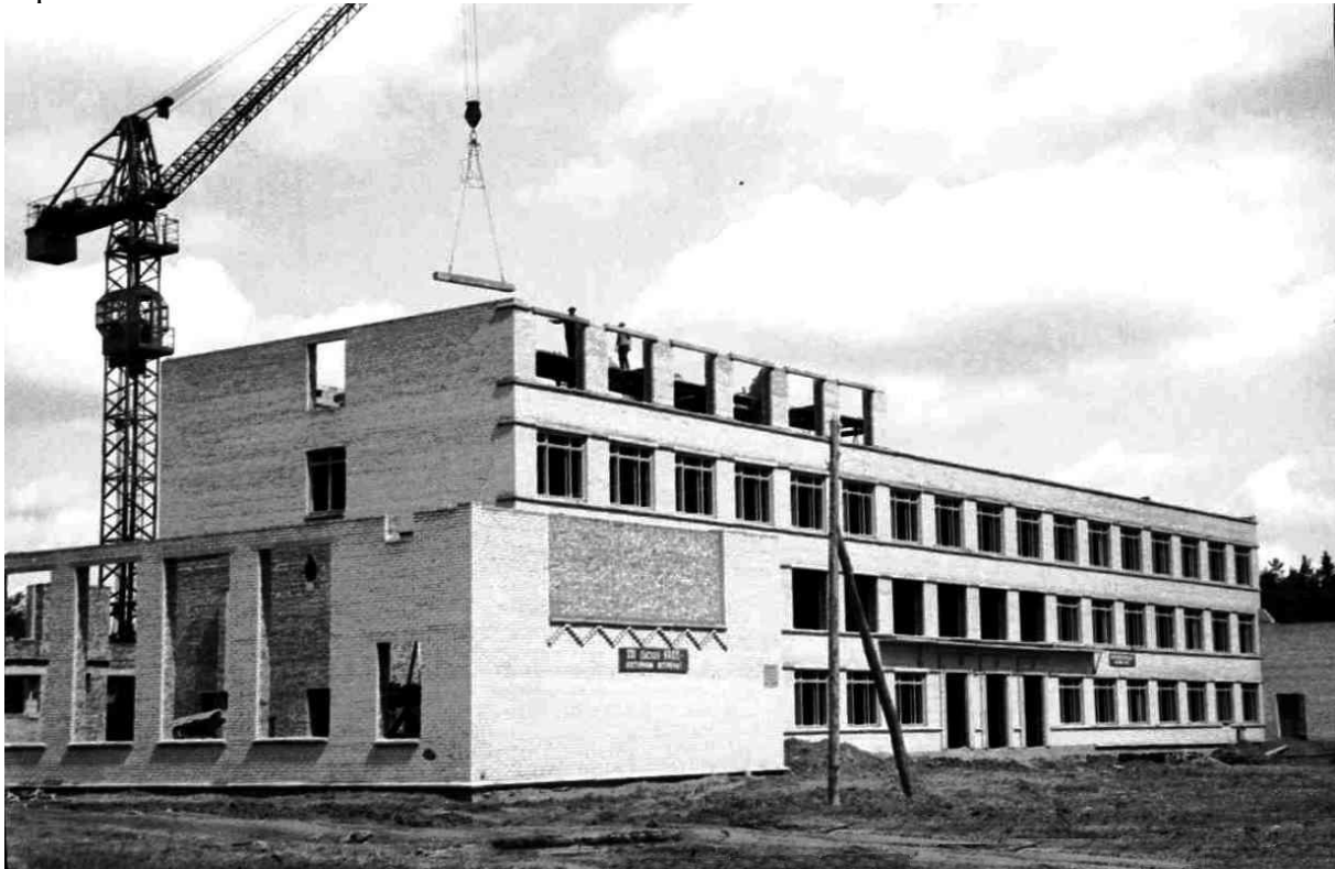
Рис. 2.67. 1960 г. Строительство главного корпуса техникума. Из коллекции музея истории Новополоцка (КП 2204-92)
