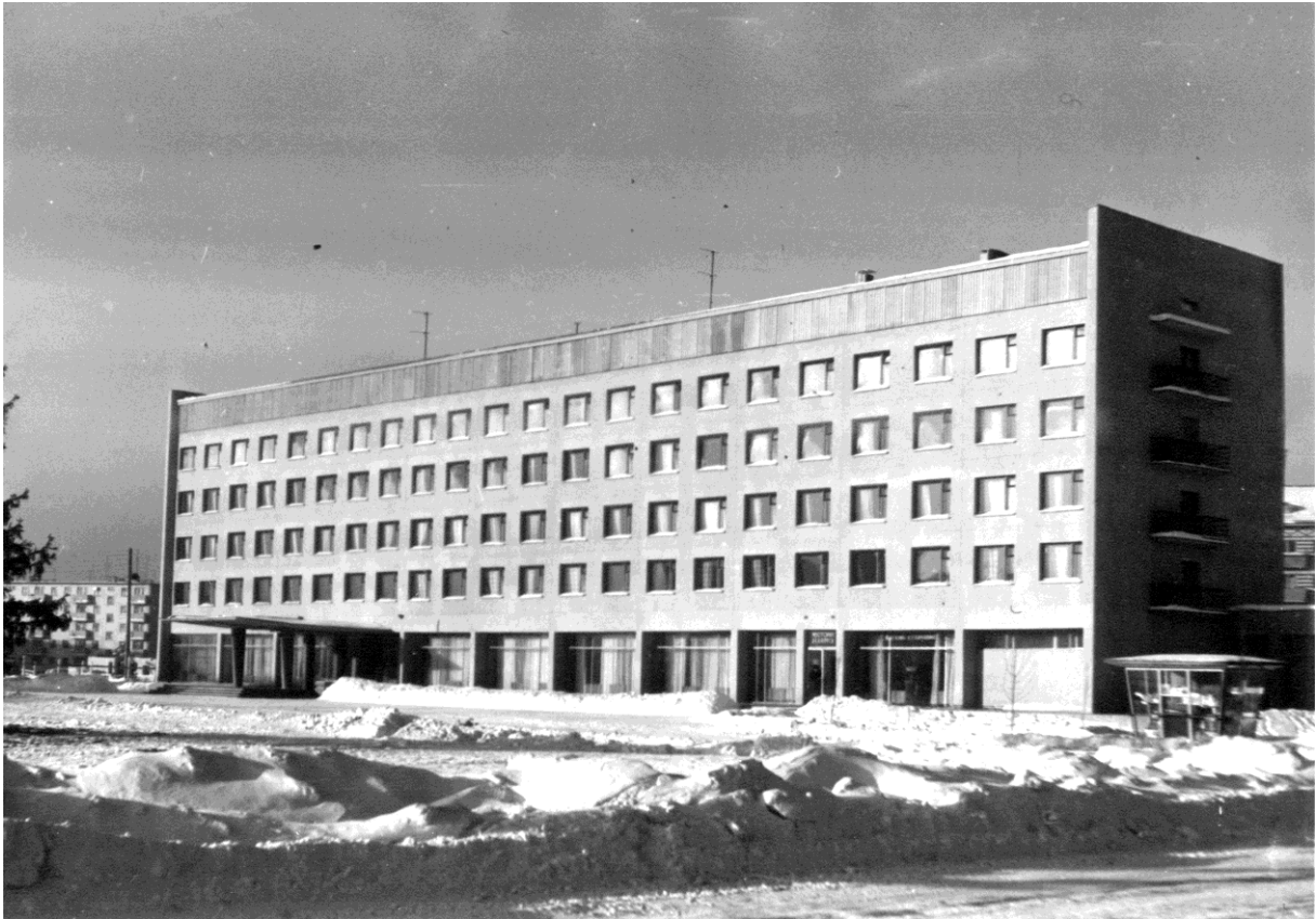
Рис. 3. 30. Общий вид гостиницы «Беларусь» после завершения строительства.
