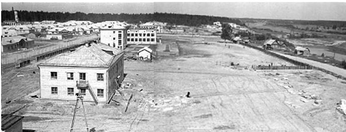
Рис. 2.36. 1959 г. Ведутся работы по благоустройству территории школы (сооружение стадиона, ограждение участка). На переднем плане детский сад. Из коллекции музея истории Новополоцка (КП 2204-81, КП 2204-82)
