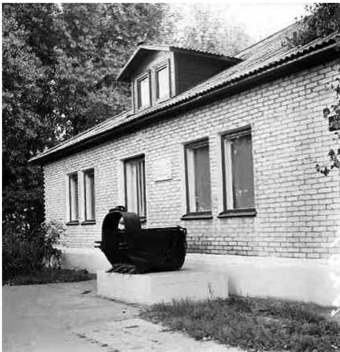
Рис. 3. 60. Общий вид здания общежития, где был оборудован музей трудовой славы Новополоцка. На переднем плане – ковш экскаватора и мемориальная доска
