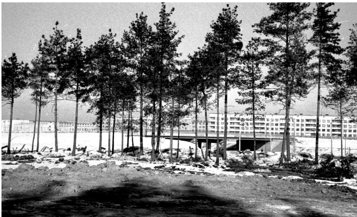
Рис. 4. 38. Общий вид строящегося путепровода № 3 по улице Калинина
