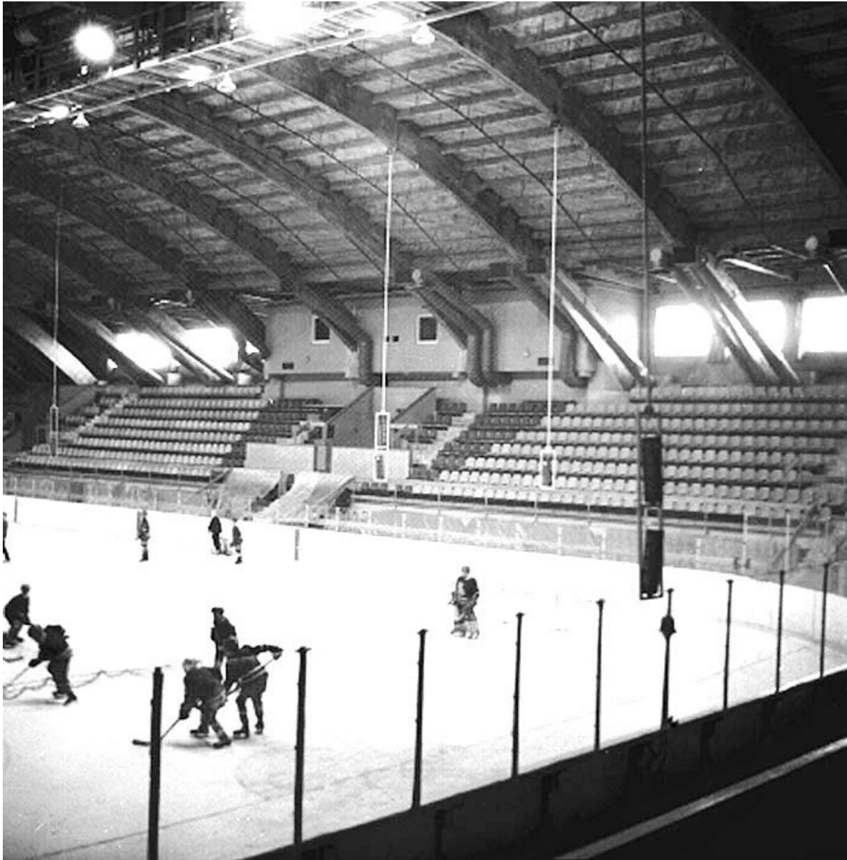
Рис. 6. 14. Интерьер Ледового Дворца после завершения строительства.
