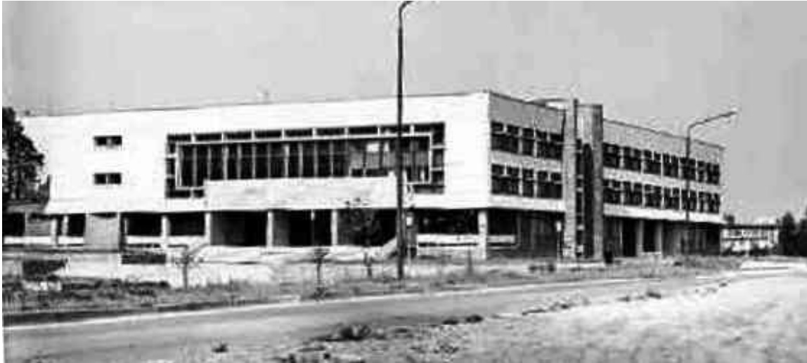
Рис. 5. 11 Общий вид школы рабочей молодежи после завершения строительства
