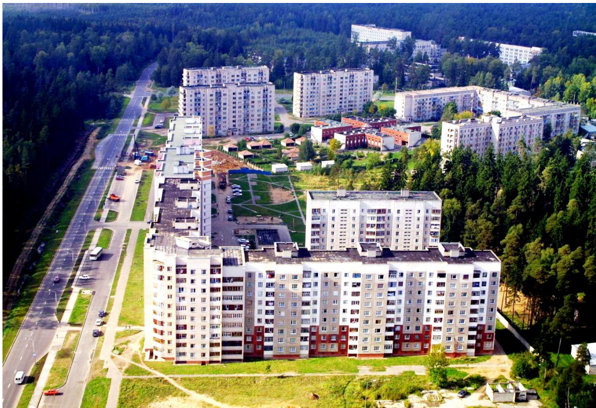
Рис. 6. 16. Общий вид жилой застройки по улице Слободской в период строительства. Фото И.В. Супроненка.
