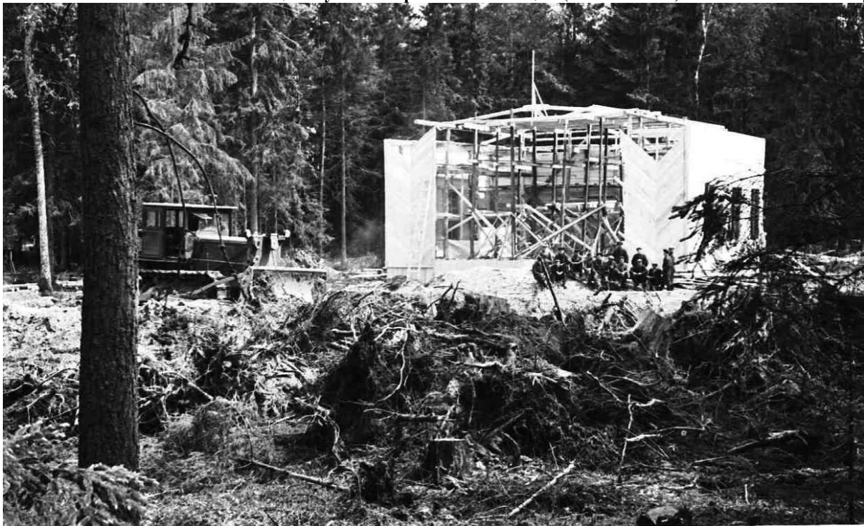
Рис. 2.45. 1959 г. Фотоснимок А.И. Васечко под названием «Строится Зелёный театр в посёлке». Из коллекции музея истории Новополюцка (КП 2203-132).
