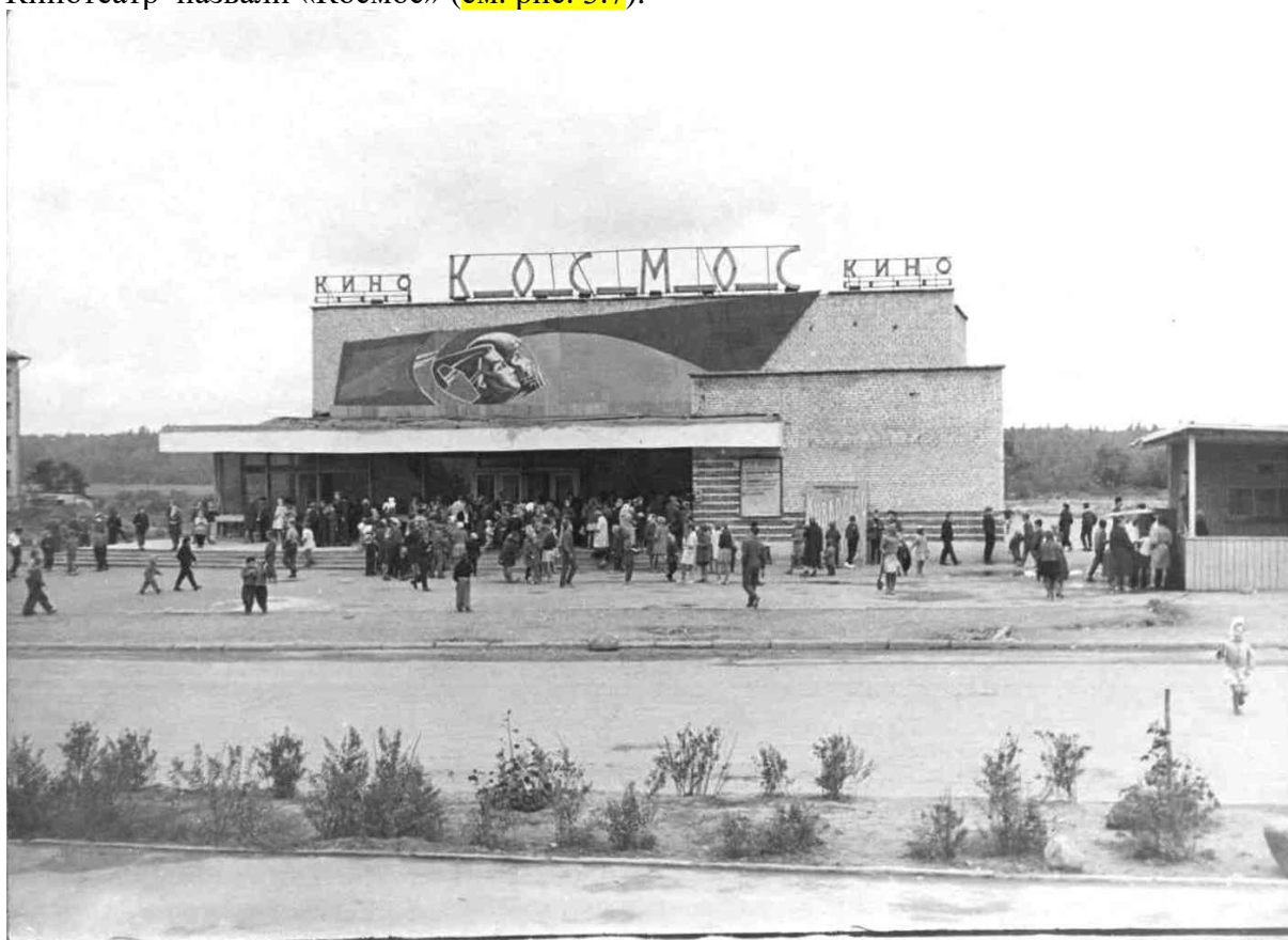
Рис. 3. 7. 1963 г. Кинотеатр «Космос» после завершения строительства.
