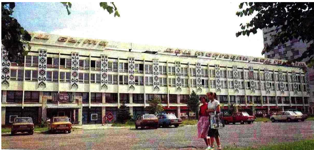
Рис. 5. 53. Общий вид зданий Домов быта и торговли после завершения строительства.
