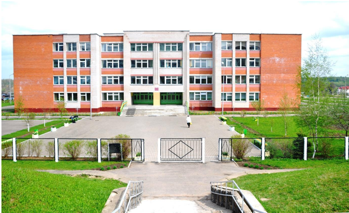
Рис. 7. 1. Общий вид общеобразовательной школы на 44 класса № 14 после завершения строительства
