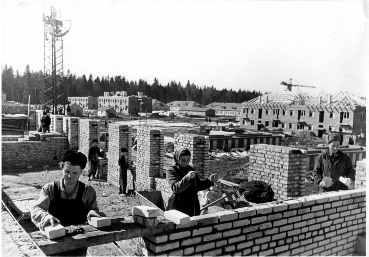
Рис. 2.41. Кирпичная кладка 24-кв. жилого дома в Пионерном городке
