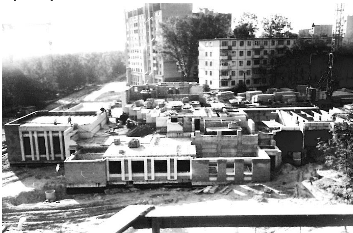
Рис. 6. 19. Жилой дом на углу улиц Ктаторова и Парковой на начальной стадии строительства.
