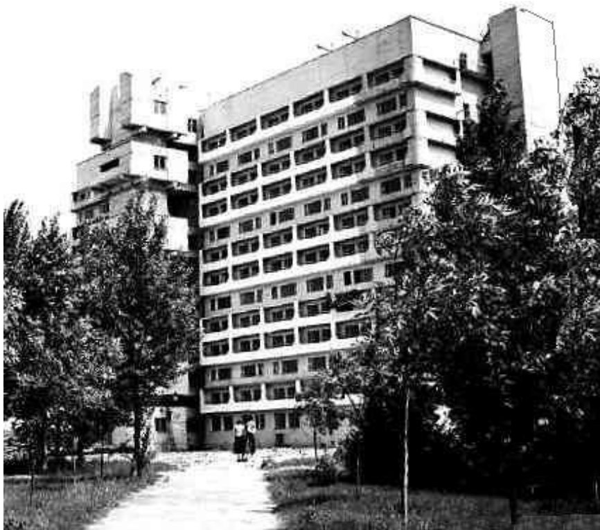
Рис. 5. 26. Общий вид общежития Новополоцкого политехнического университета после завершения строительства
