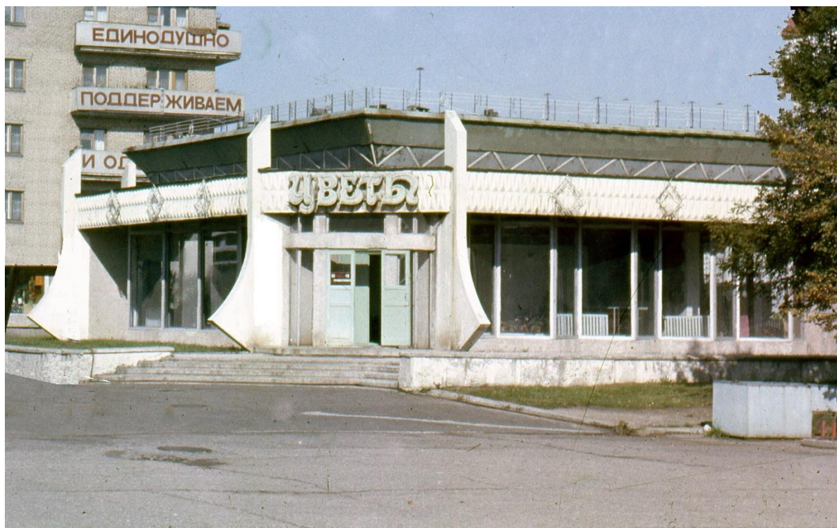
Рис. 4. 106. Общий вид магазина «Цветы» на площади Строителей после завершения строительства
