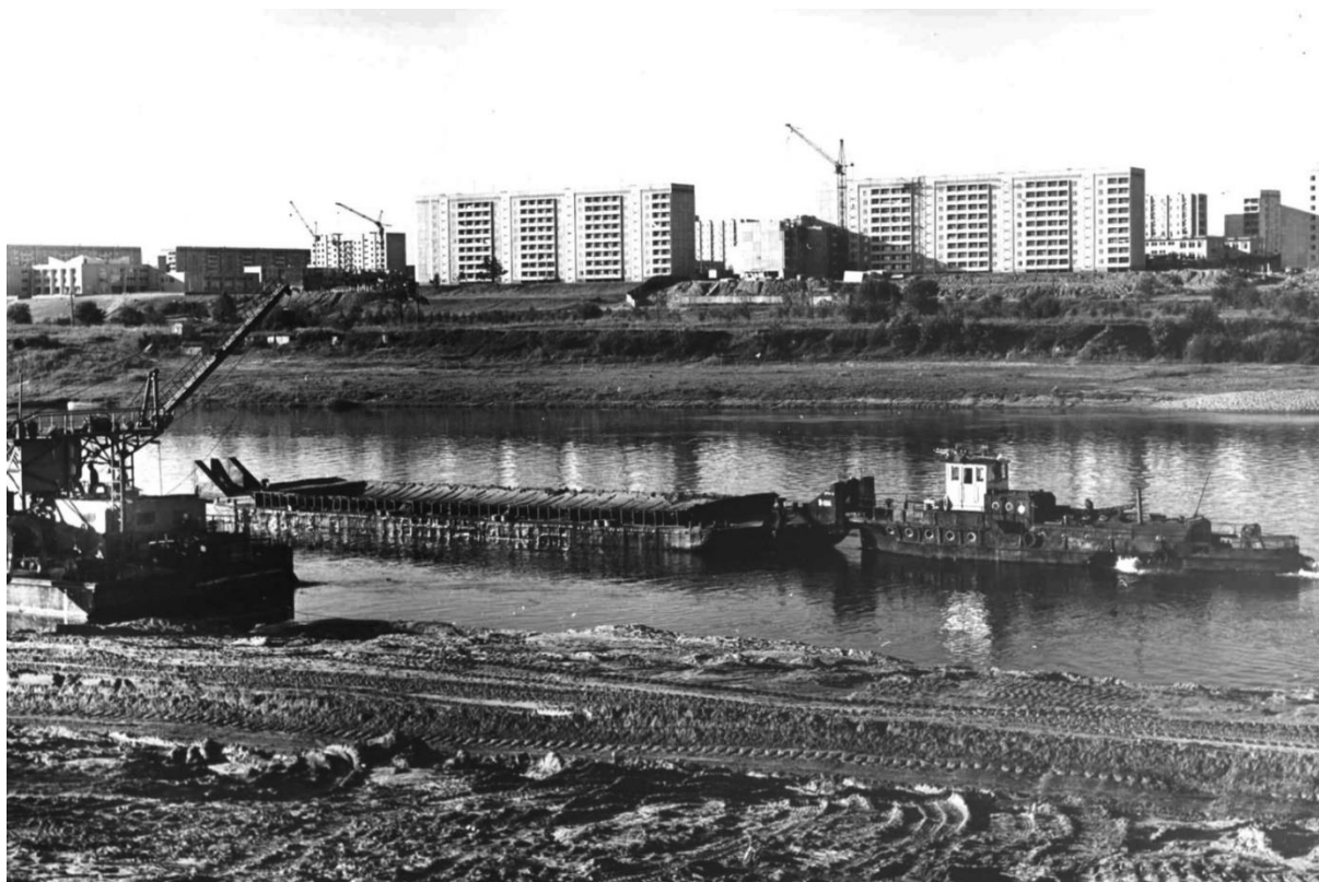
Рис. 4. 89. Общий вид строительства крупнопанельных жилых домов по улице Парковой (теперь Я. Колоса) у въезда в город
