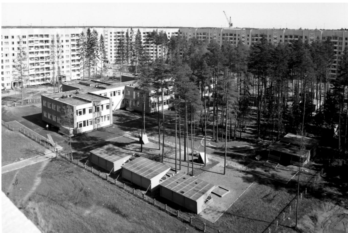
Рис. 5. 31. Общий вид детского сада-яслей № 28 на 280 мест после завершения строительства
