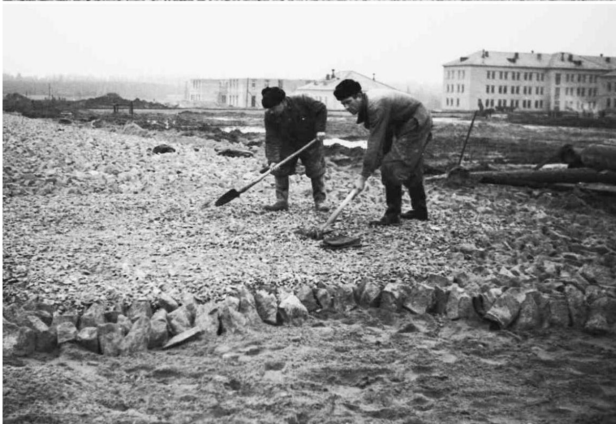
Рис. 2.68. 1959-1960 гг. Сооружение бетонных дорог. Из коллекции музея истории Новополюцка (КП 2203-166, 174
