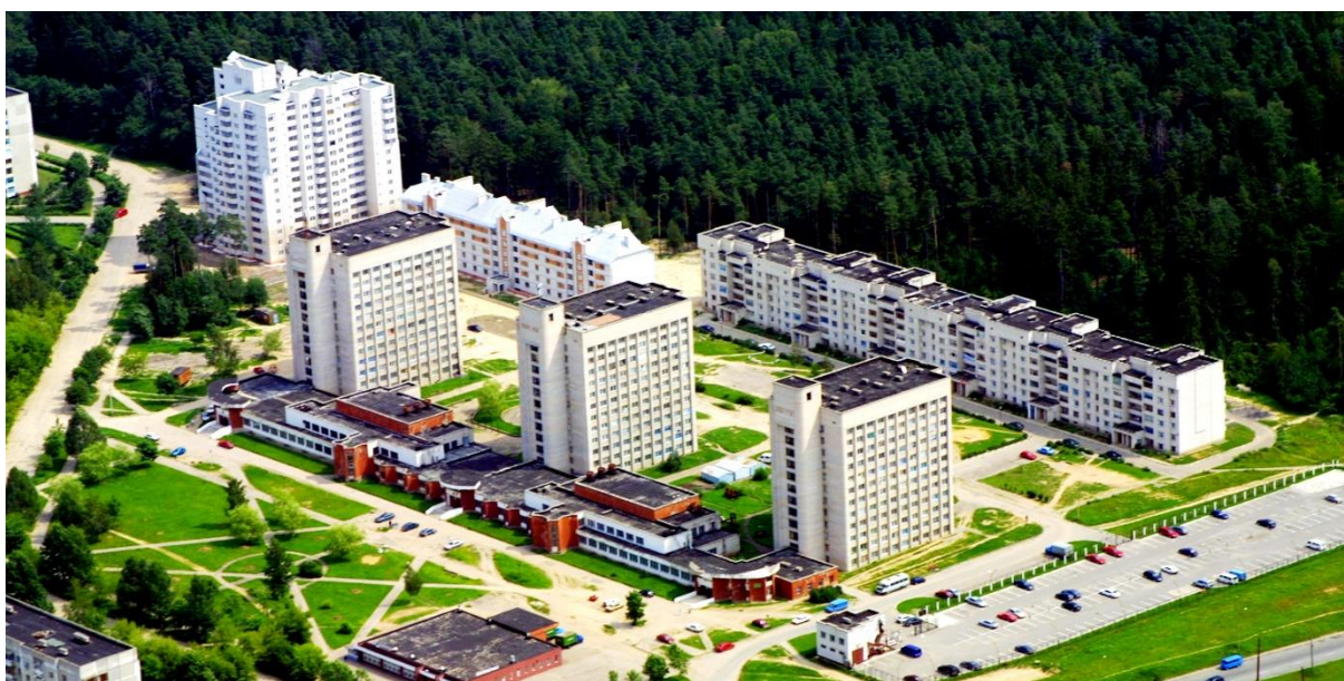
Рис. 7. 12. Панорама застройки района общежитий завода «Измеритель» с 14-этажным жилым домом. Фото И.В. Супроненка
