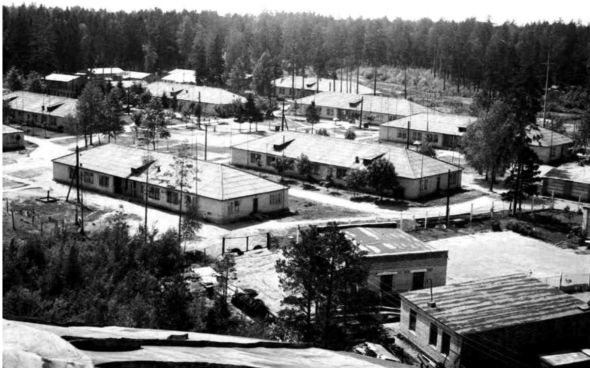
Рис. 2.87. 1961 г. Поселок Энергостроителей. Из коллекции музея истории Новополоцка (КП 2227-1) под названием «Общежития работников и строителей ТЭЦ-2»
