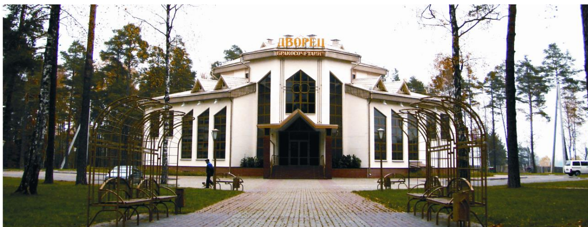
Рис. 7. 29. Дворец бракосочетаний после ввода в эксплуатацию.
