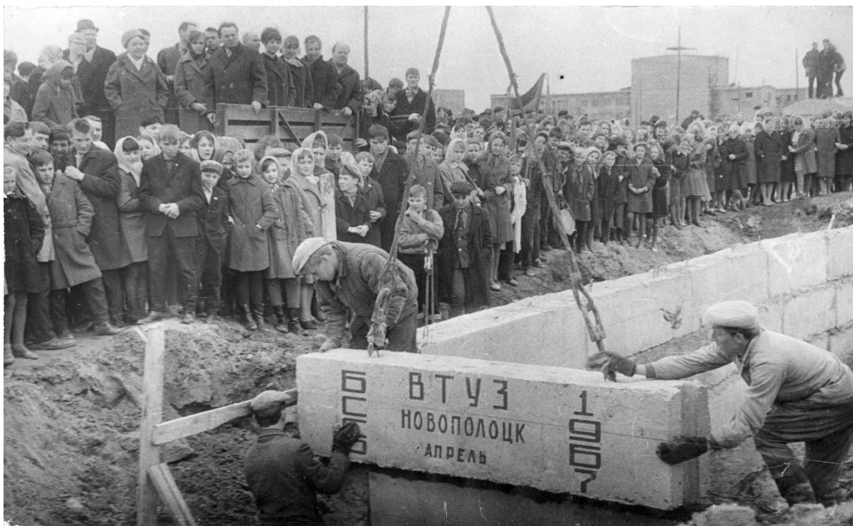
Рис. 3. 44. Начало сооружения учебно-лабораторного корпуса высшего технического учебного заведения. Закладка плиты – фундаментного блока с памятной надписью.
