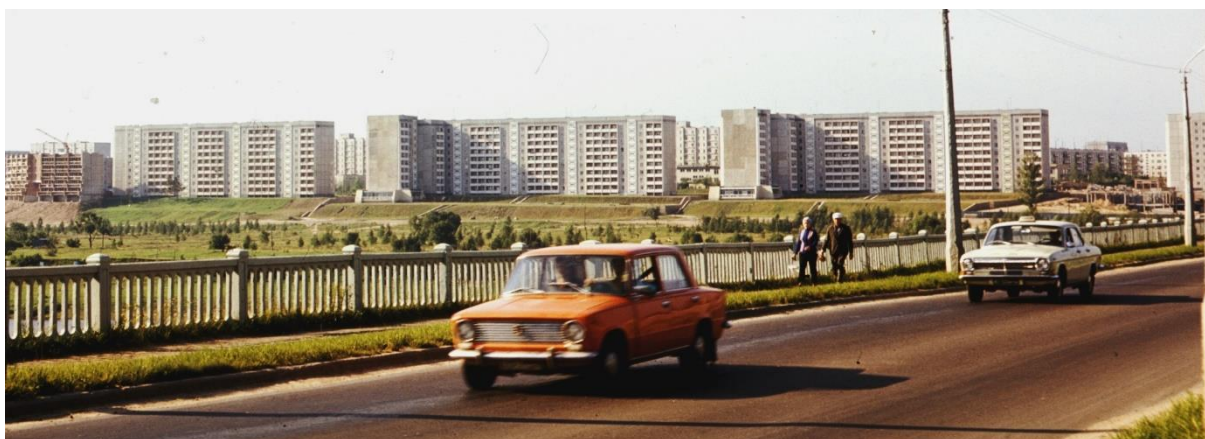
Рис. 5. 2. Общий вид крупнопанельных жилых домов по улице Парковой на въезде в город после завершения строительства
