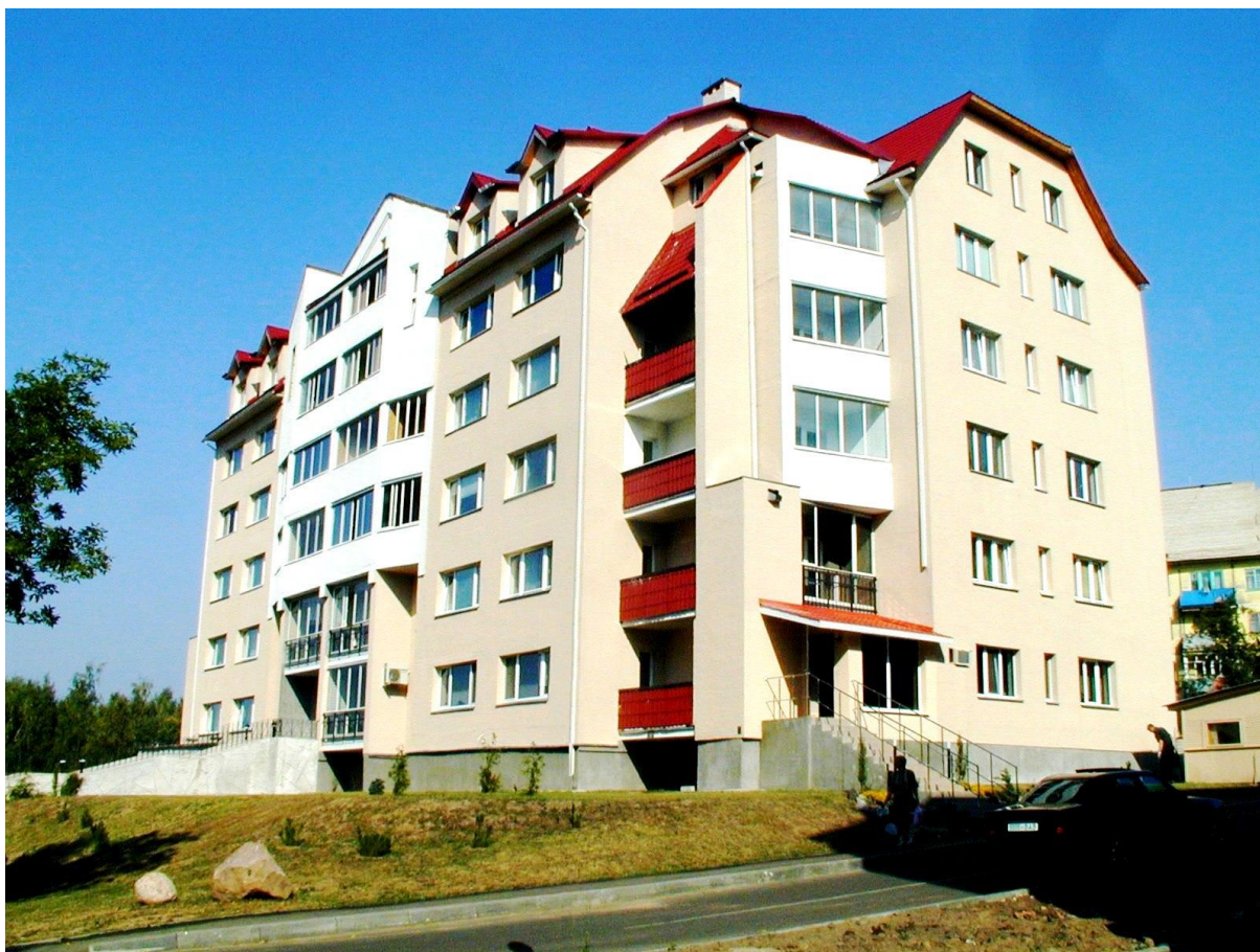
Рис. 7. 11. Жилой дом на углу улиц Кгаторова и Парковой после завершения строительства. Архитектор А.И. Грешной
