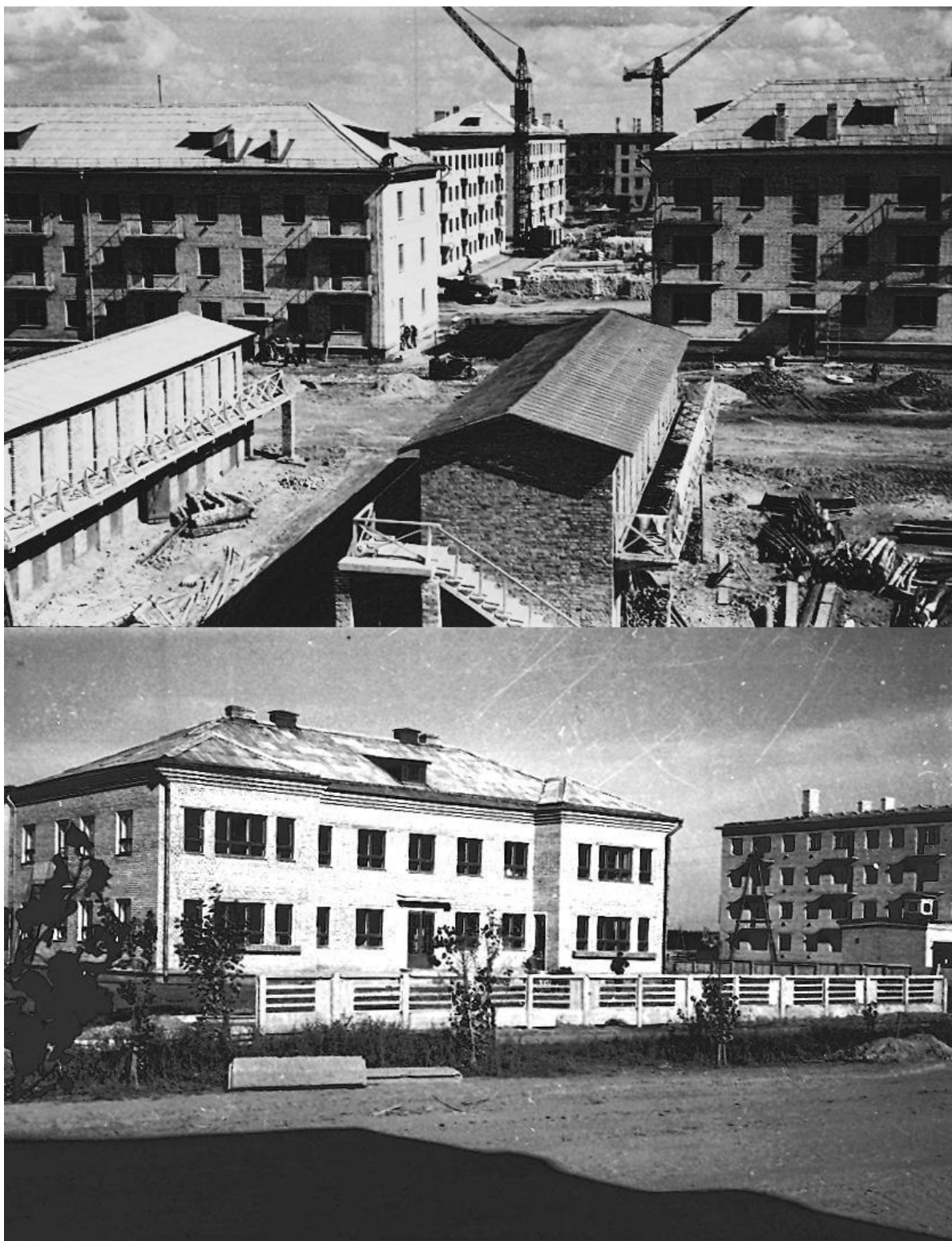
Рис. 2.59. 1960 г. Вверху: строящиеся 24-квартирные жилые дома с дровяниками для хозяйственных нужд; внизу: детские ясли на 120 мест после завершения строительства
