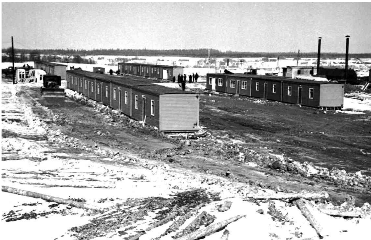
Рис. 2. 78. Фотоснимок строящегося инвентарного городка для строителей теплоэлектростанции. Из коллекции музея истории Новополоцка под названием «Бытовки строителей ТЭЦ» (КП 2204-125.)
