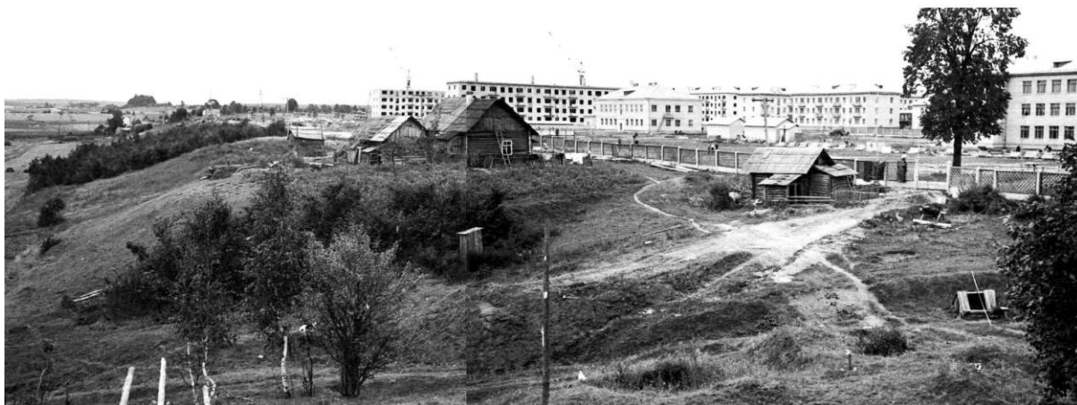
Рис. 2.62. 1960 г. Фотопанорама строительства «многоэтажных» жилых домов у деревни Слобода. Из коллекции музея истории Новополюцка (КП 2203-104)
