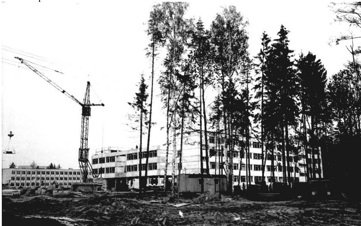
Рис. 5. 23. Общий вид строительной площадки общеобразовательной школы № 9
