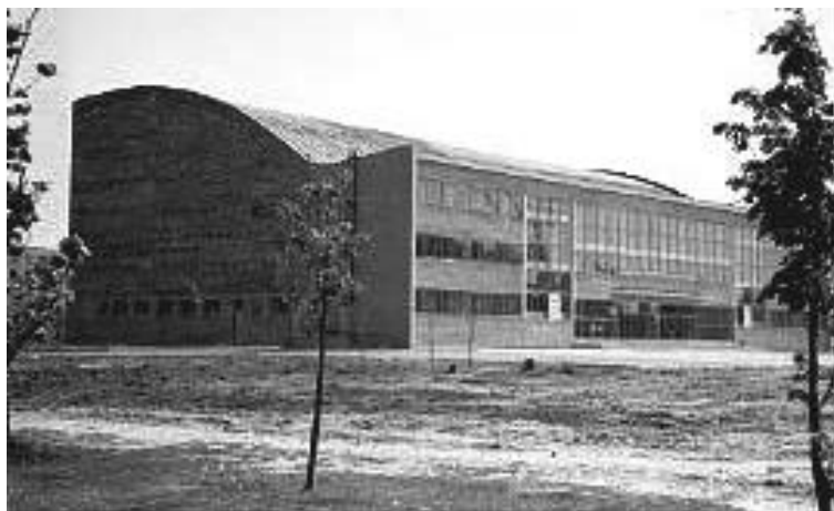
Рис. 4. 63. Общий вид строящегося здания плавательного бассейна
