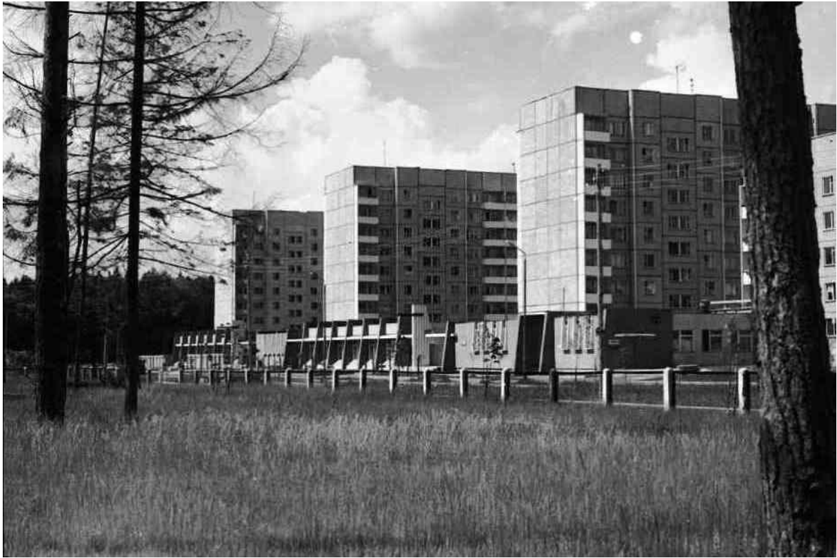
Массовое строительство велось в микрорайоне № 4 (см. рис. 4.80). Четко Рис. 4. 79. Общий вид части улицы Дружбы с жилыми домами №№ 6 (552), 8 (553), 10 (554)
