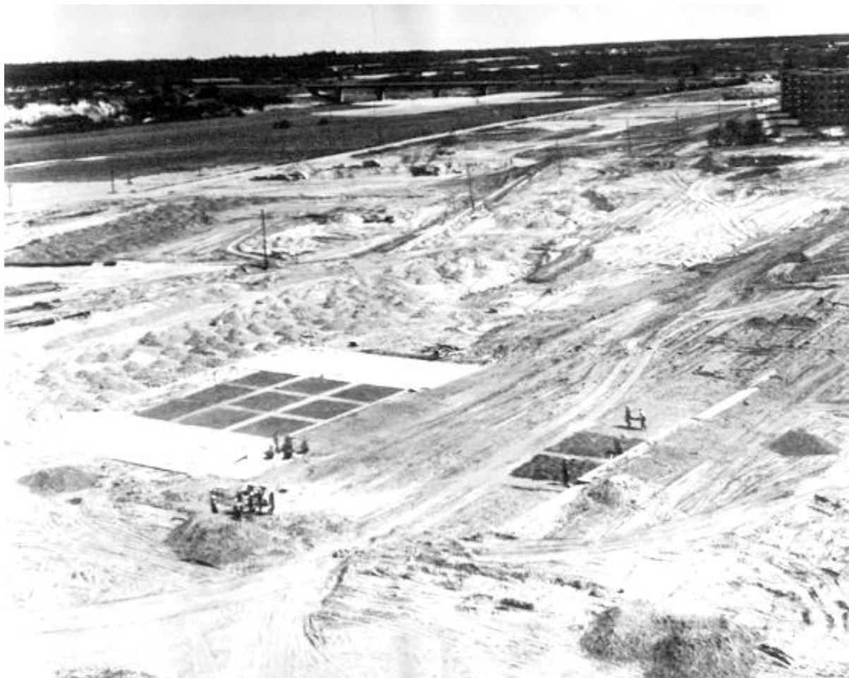
Рис. 3. 36. 1967 г.Строительные работы по сооружению стадиона «Атлант».
