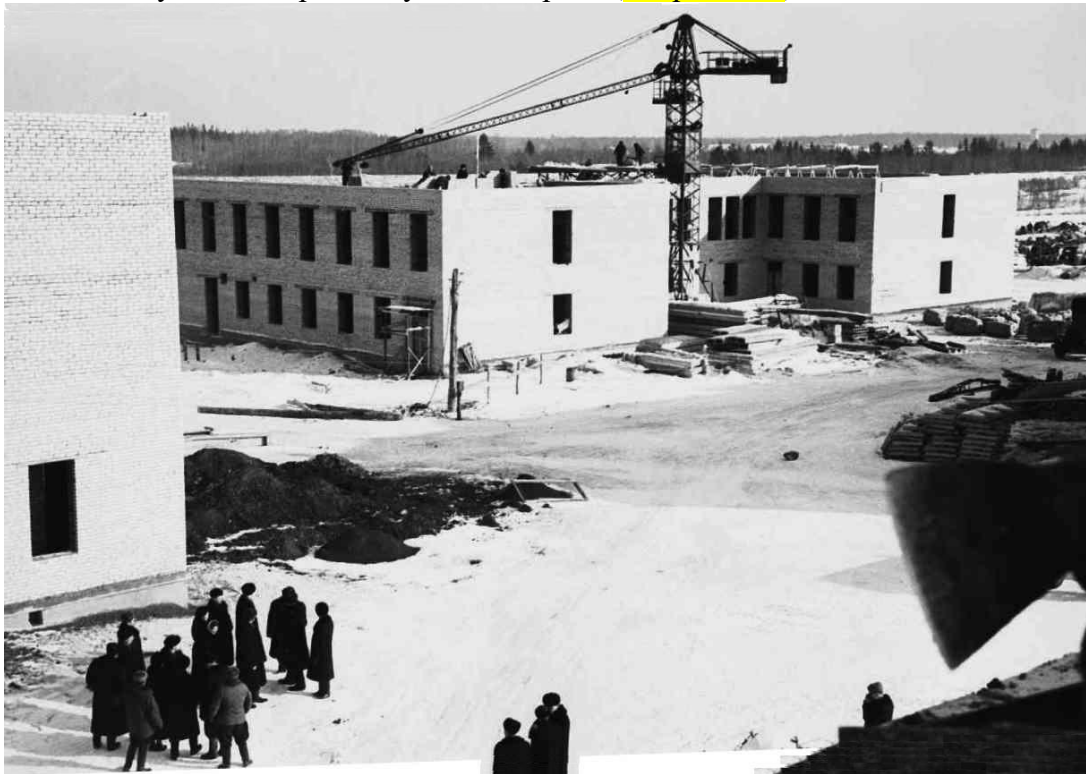
Рис. 2.89. 1960 г. Строительство столовой в административной зоне нефтеперерабатывающего завода. Из коллекции музея истории Новополоцка (КП2204-172)
