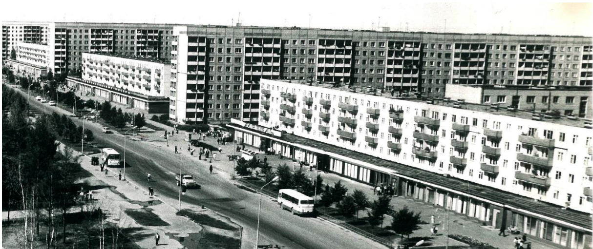
Рис. 4. 80. Общий вид ул. Молодежной в микрорайоне № 4 после возведения 9-тиэтажных крупнопанельных жилых домов
