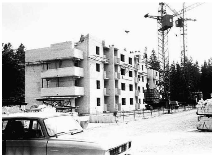
Рис. 5.. 24. Общий вид строящегося жилого дома для малосемейных при реконструкции поселка Энергостроителей
