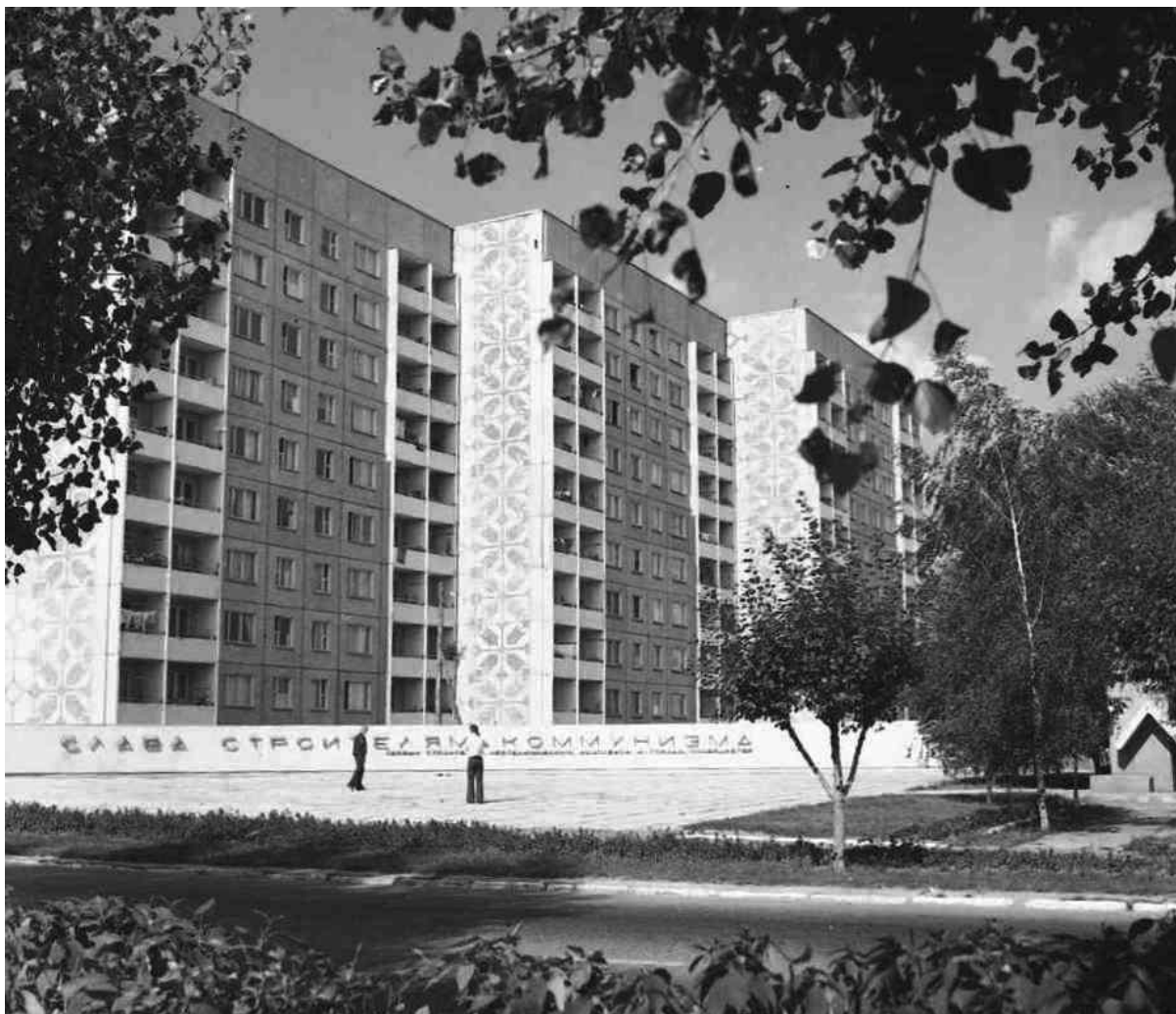
Рис. 4.64. Общий вид жилого дома № 5 по улице Молодежной после завершения строительства
