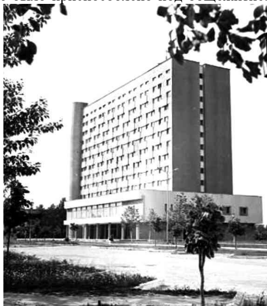
Рис. 5. 8. Общий вид общежития завода белково-витаминных концентратов) по улице Кирова после завершения строительства
