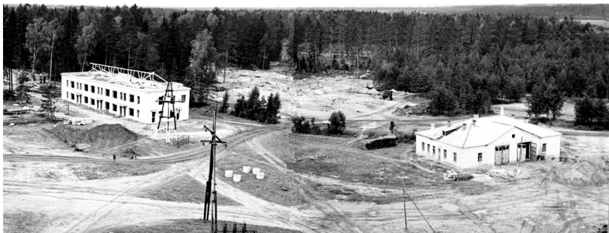
Рис. 2.66. Панорама строительства инфекционного корпуса больницы. На переднем плане здание пожарного депо.
