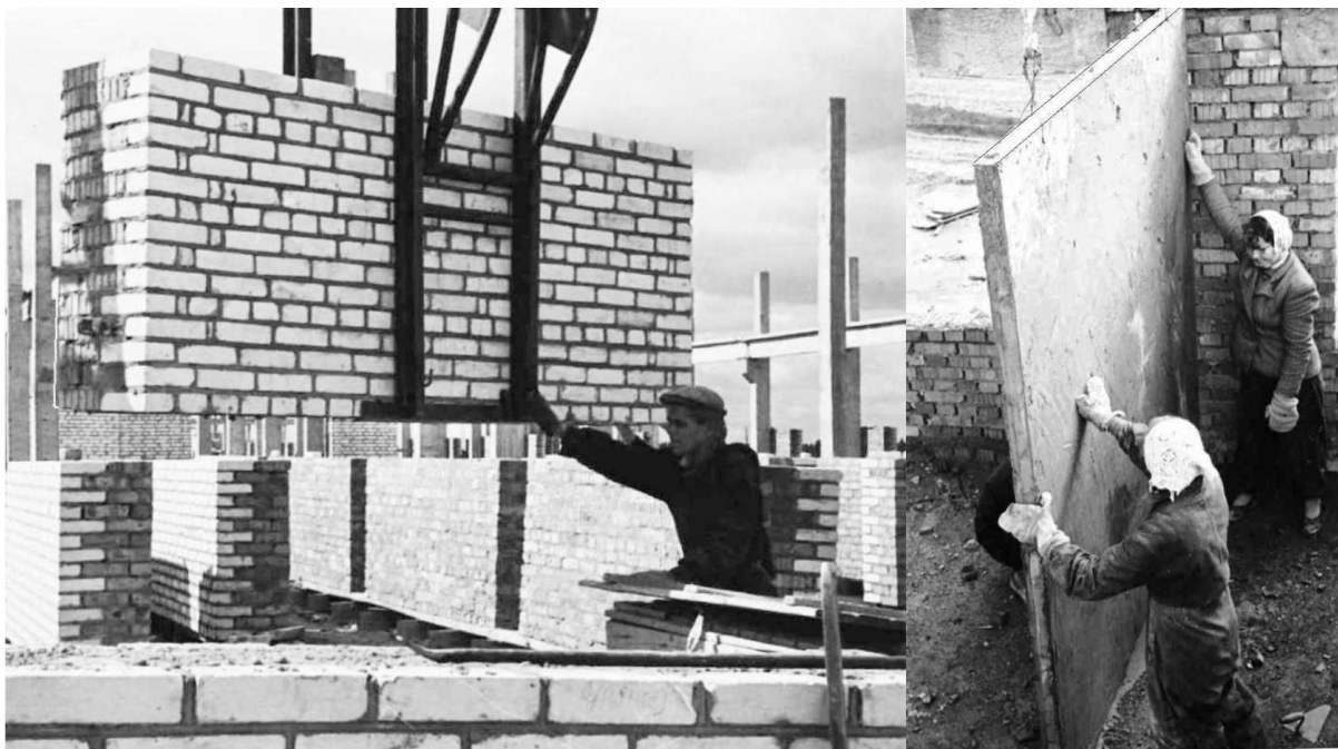
Рис. 2.93. Фотоснимки из коллекции музея истории Новополоцка под названием: «Кладка стен блоками со склада ЖБИ» (КП 2203-179) и «Установка перегородок в жилом доме. (КП 2204-177),
