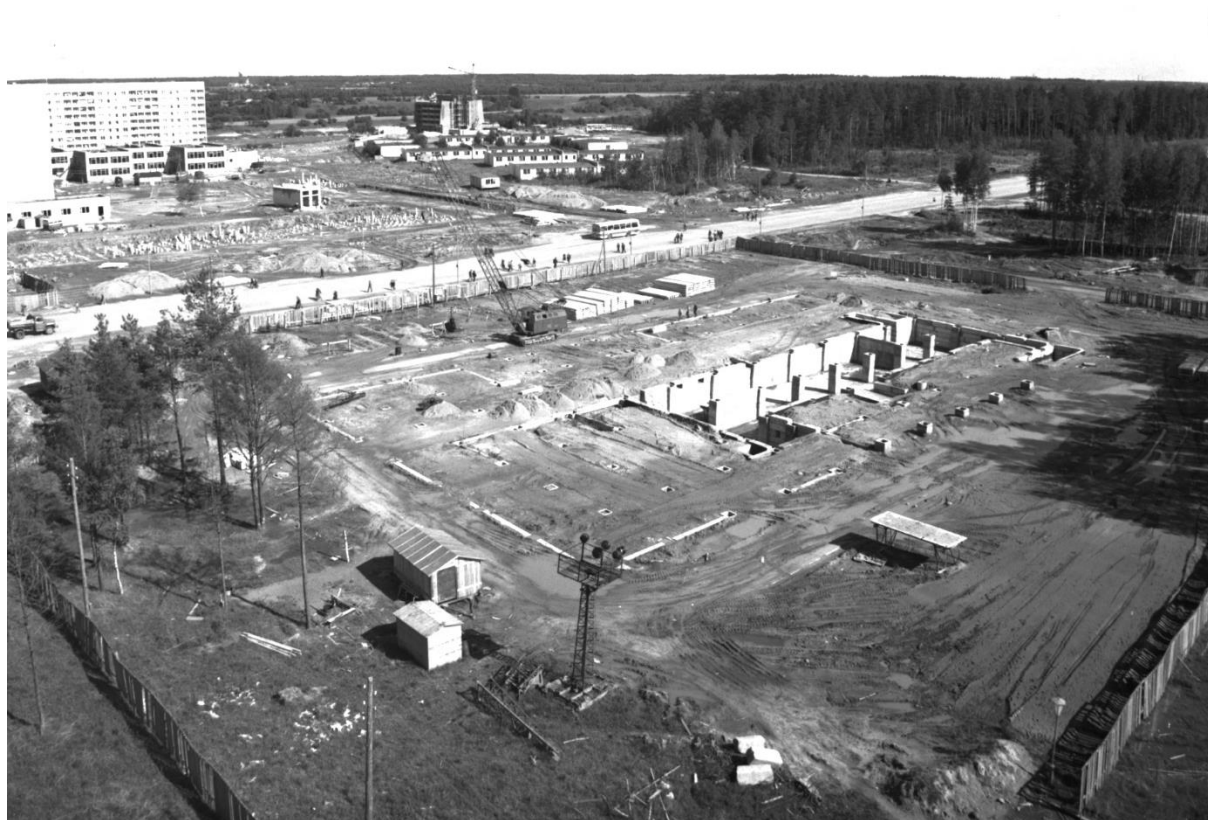
Рис. 4. 99. Общий вид строительной площадки при закладке фундаментов под кооперированное здание кинотеатра, кафе и танцевального зала в микрорайоне № 6 по улице Молодежной.
