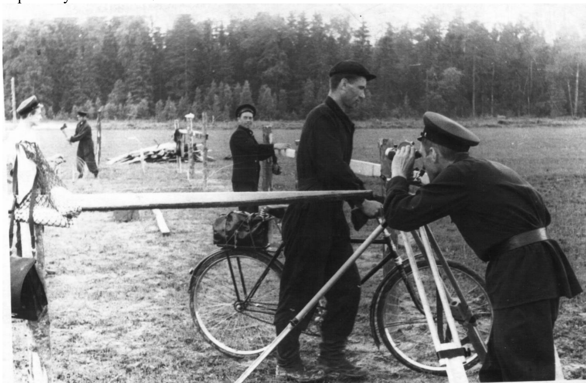
Рис. 2. 6. 1958 г. Геодезические работы по разбивке первых общежитий
