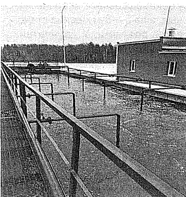
Реконструкция очистных сооружений канализации в Фариново Полоцкого района.
