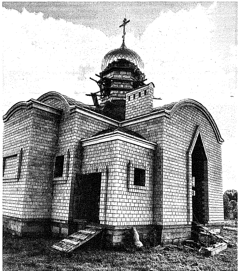
Для завершения строительства храма нужна помощь.
